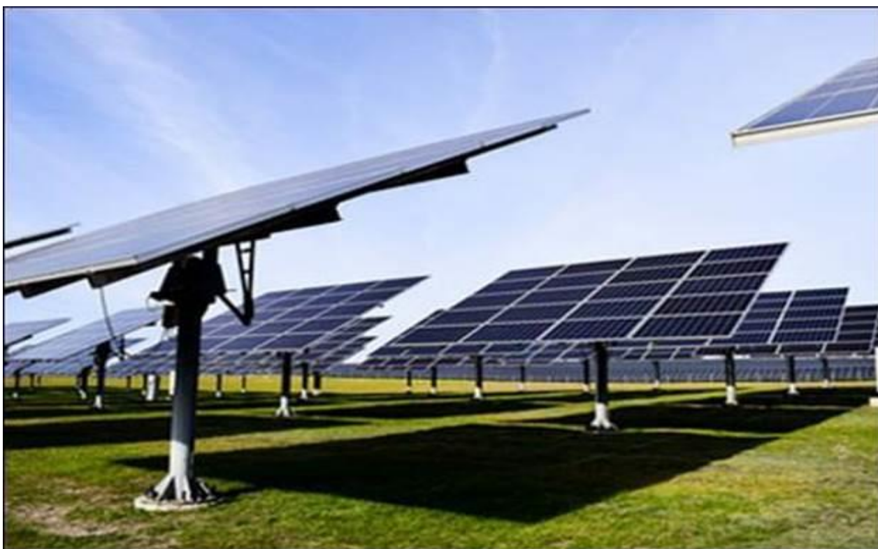
Rycina 6. Konstrukcja śledząca ruch słońca przeznaczona do posadowienia paneli fotowoltaicznych.
