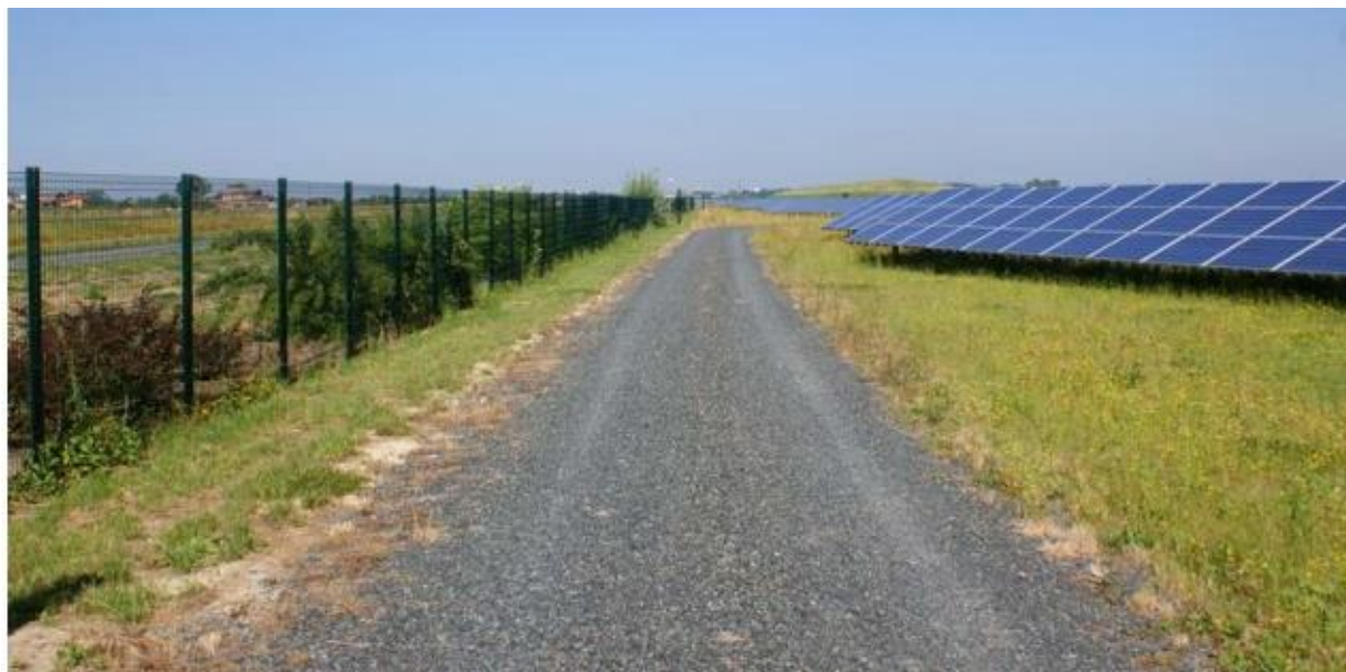
Fot. 1. Widok na przykładowe zastosowanie drogi technologicznej
