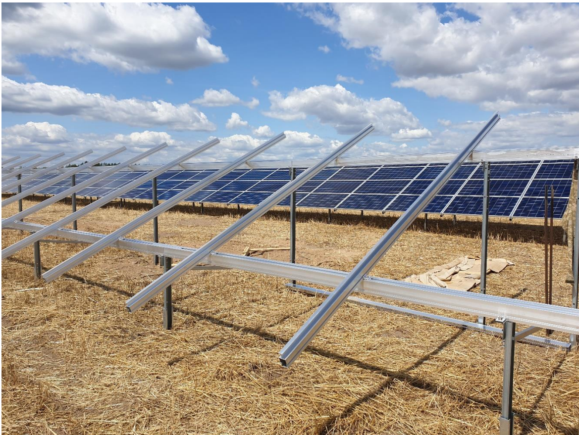
Fot. 1. Konstrukcja stołu z panelami fotowoltaicznymi.
