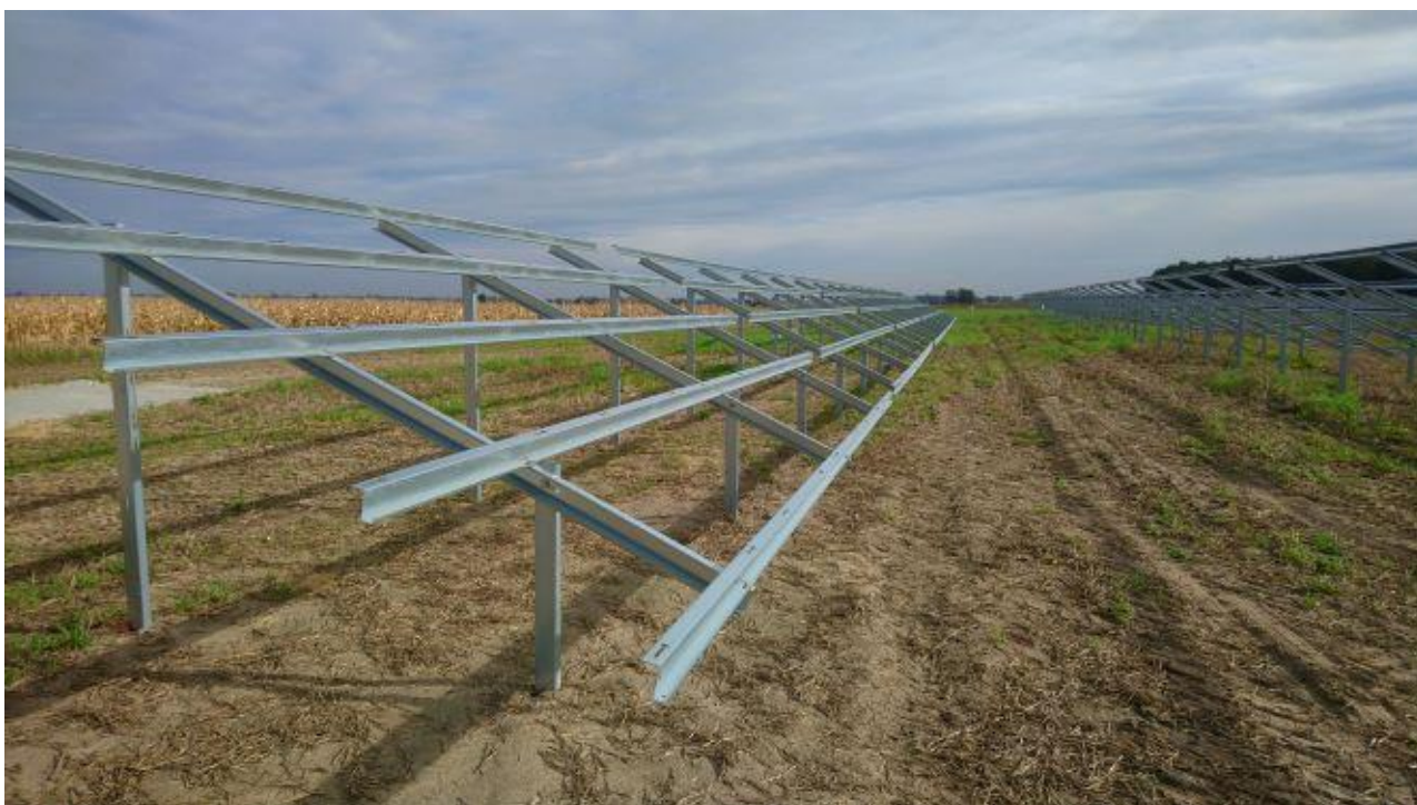
Rycina 14. Szkielety przed montażem paneli.
