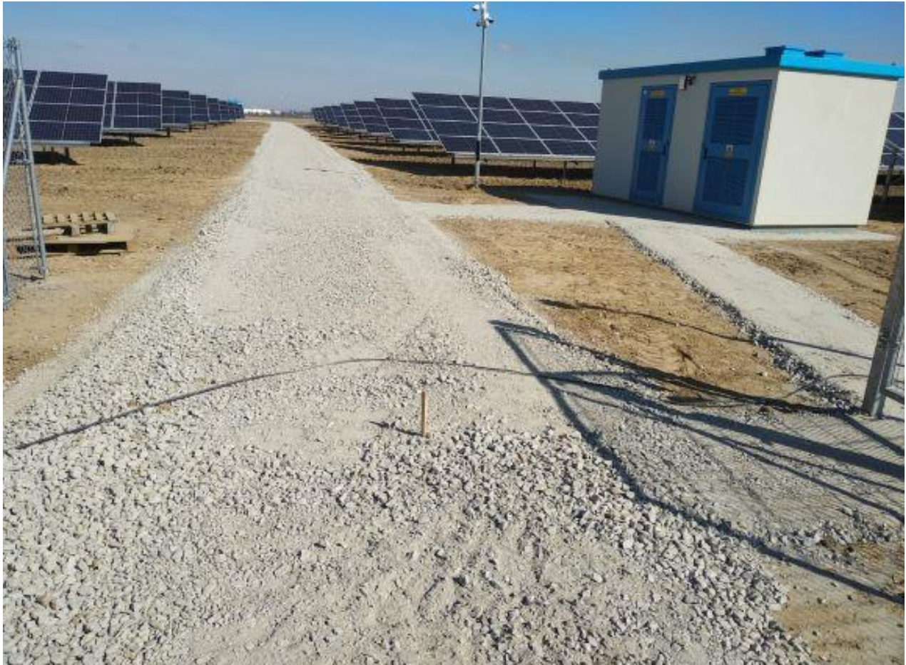
Rycina 2. Przykładowa droga techniczna.
