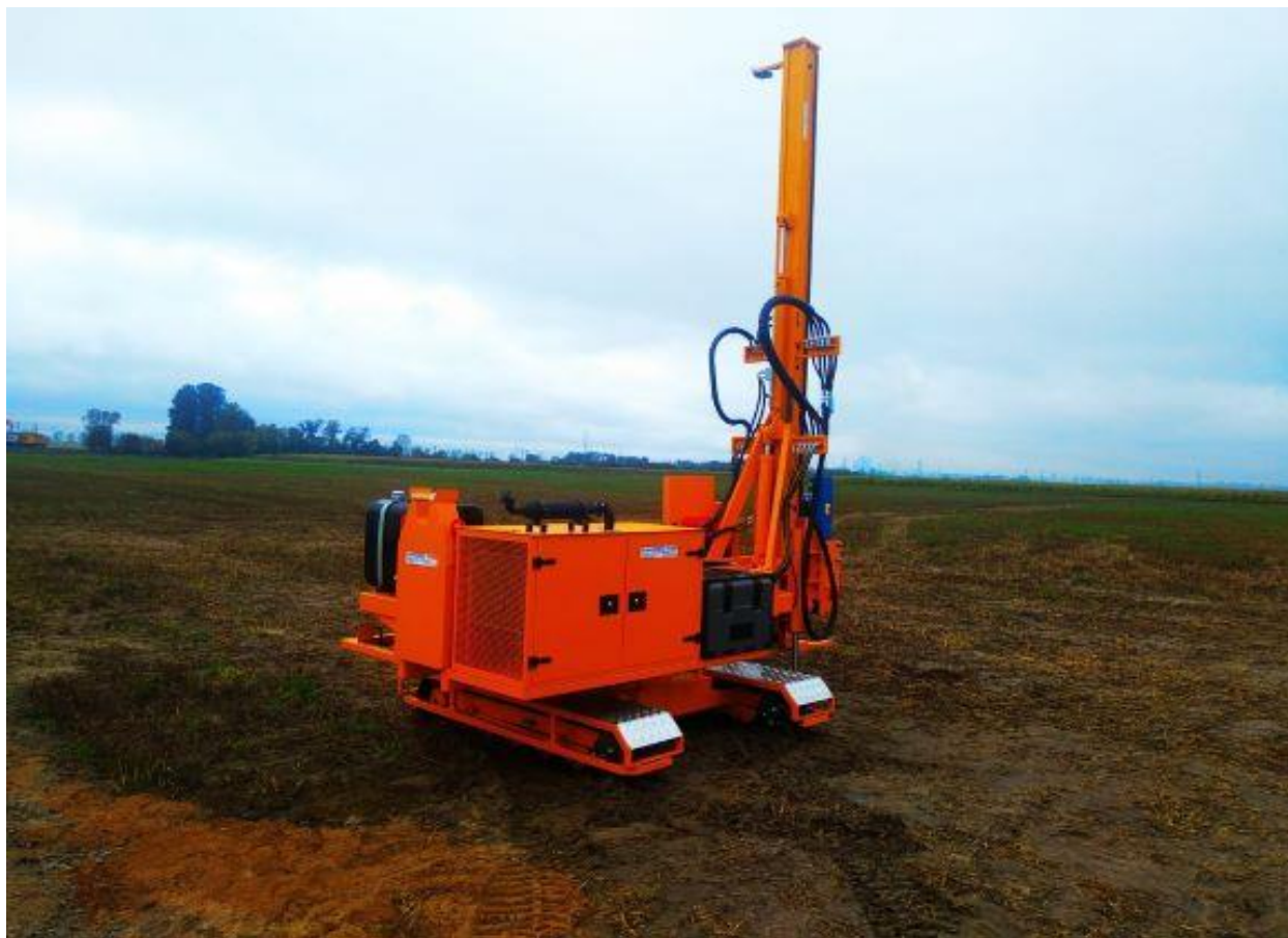
Rycina 4. Budowa konstrukcji za pomocą kafara.
