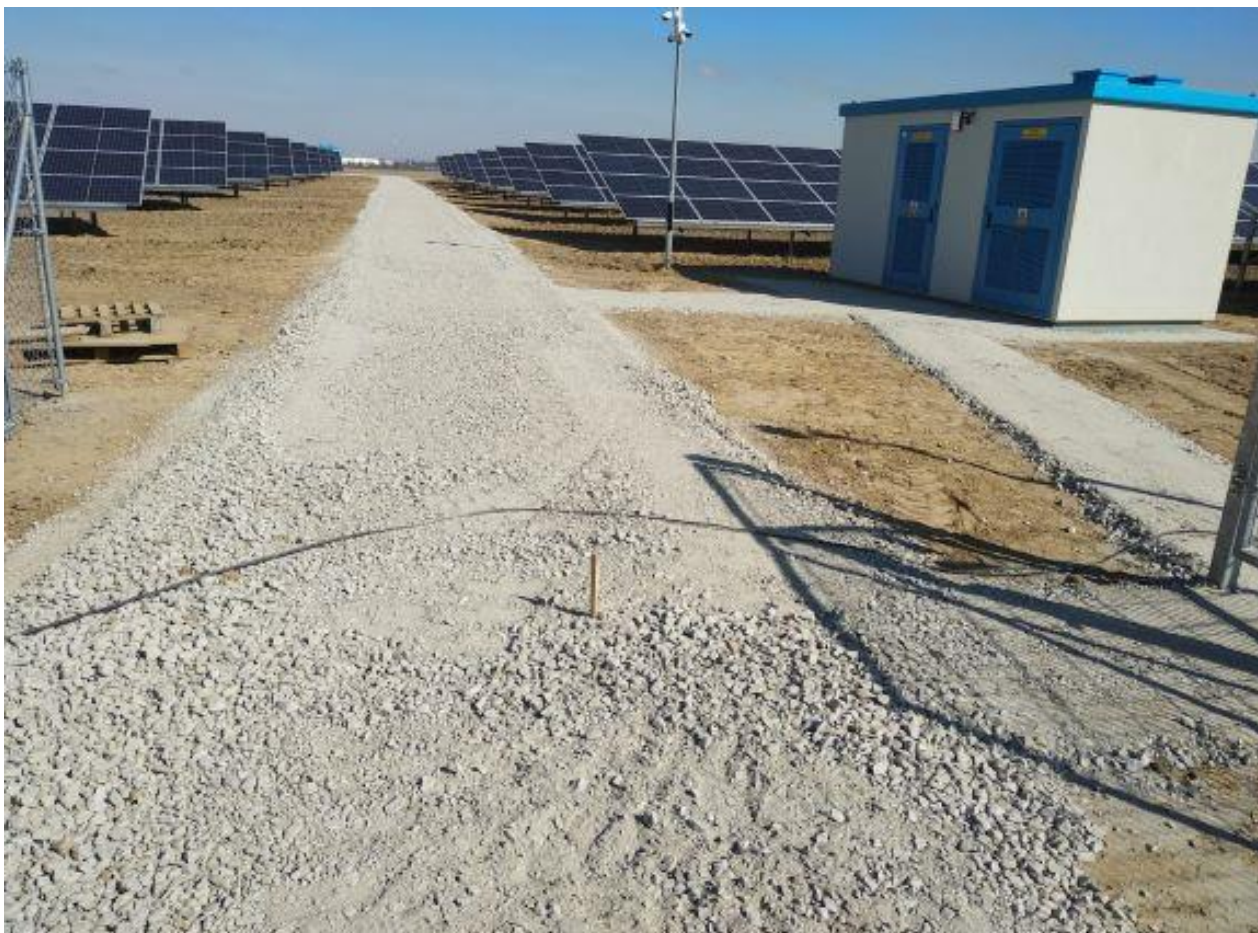
Rycina 1. Przykładowa droga techniczna.
