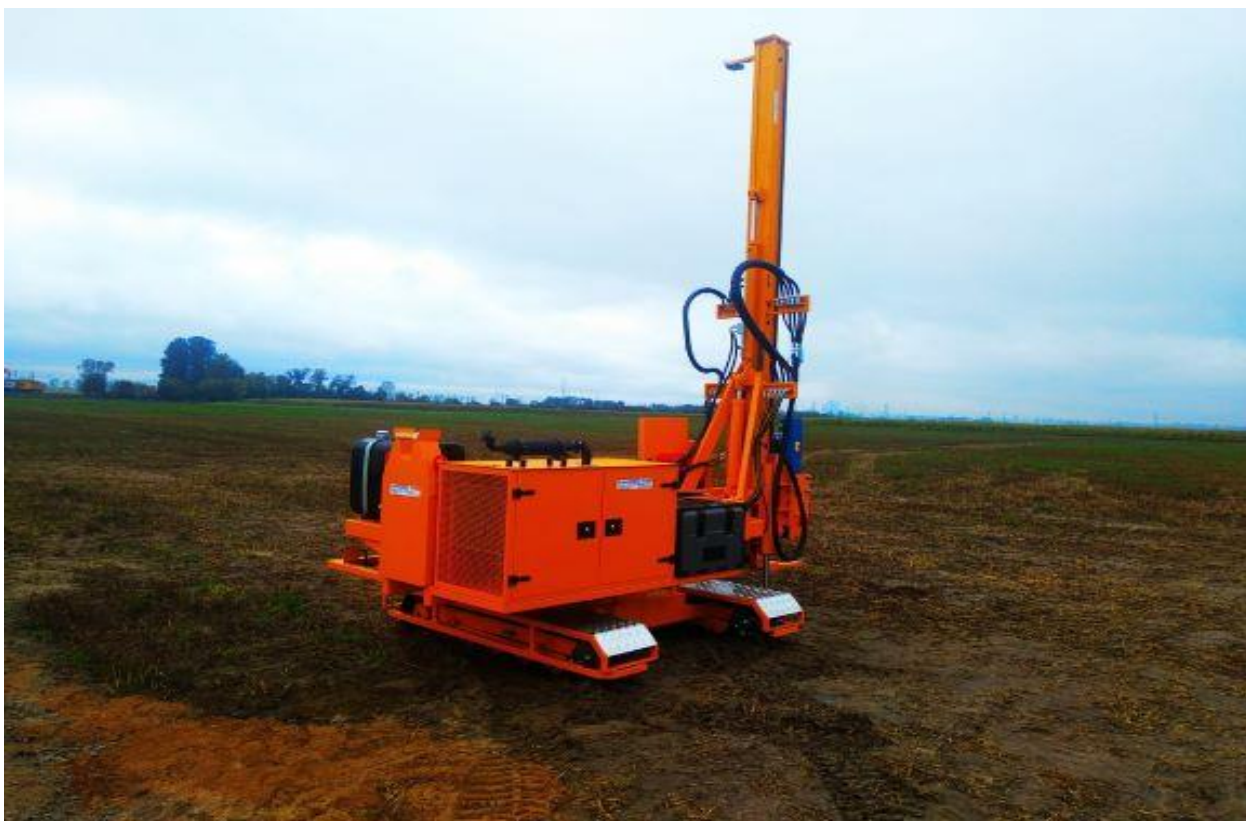
Rycina 4. Budowa konstrukcji za pomocą kafara.
