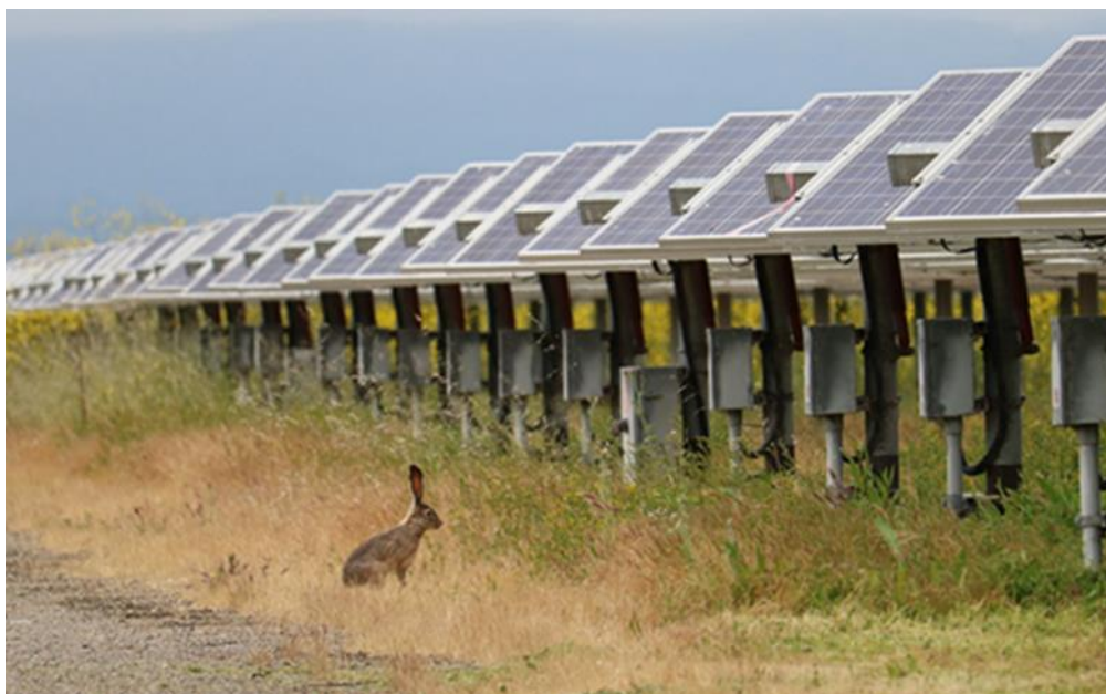
Fot. 5 Odpowiednio wykonane ogrodzenie farmy fotowoltaicznej zapewnia możliwość migracji i żerowania małym i średnim zwierzętom (Źródło: https://www.rpcs.com/wp-content/uploads/2019/03/Solar-and-Wildlife_RPCS.pdf )
