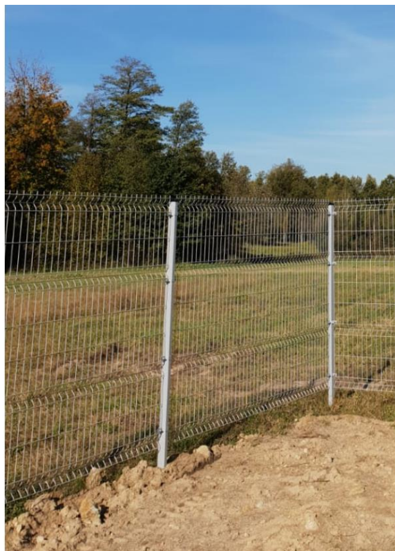
Fot. 5. Ażurowe ogrodzenie farmy fotowoltaicznej z zachowaną przerwą dla migracji małych zwierząt. Źródło: materiały własne firmy ALSEVA INNOWACJE S.A.
