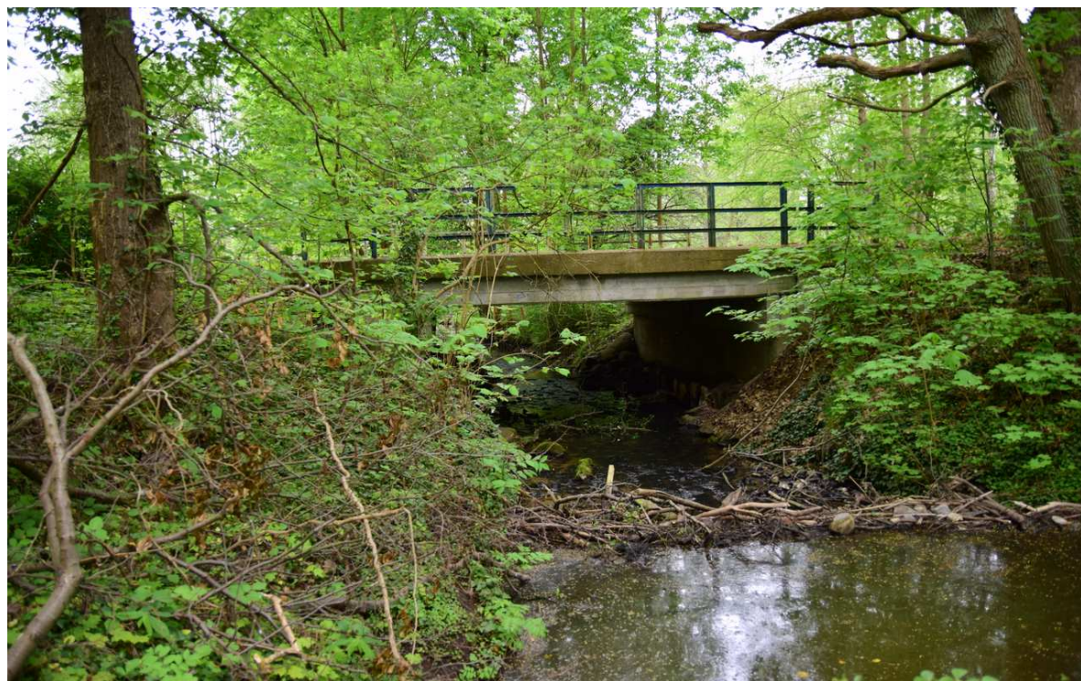
Rys. 3.3. Widok mostu od strony wody górnej
