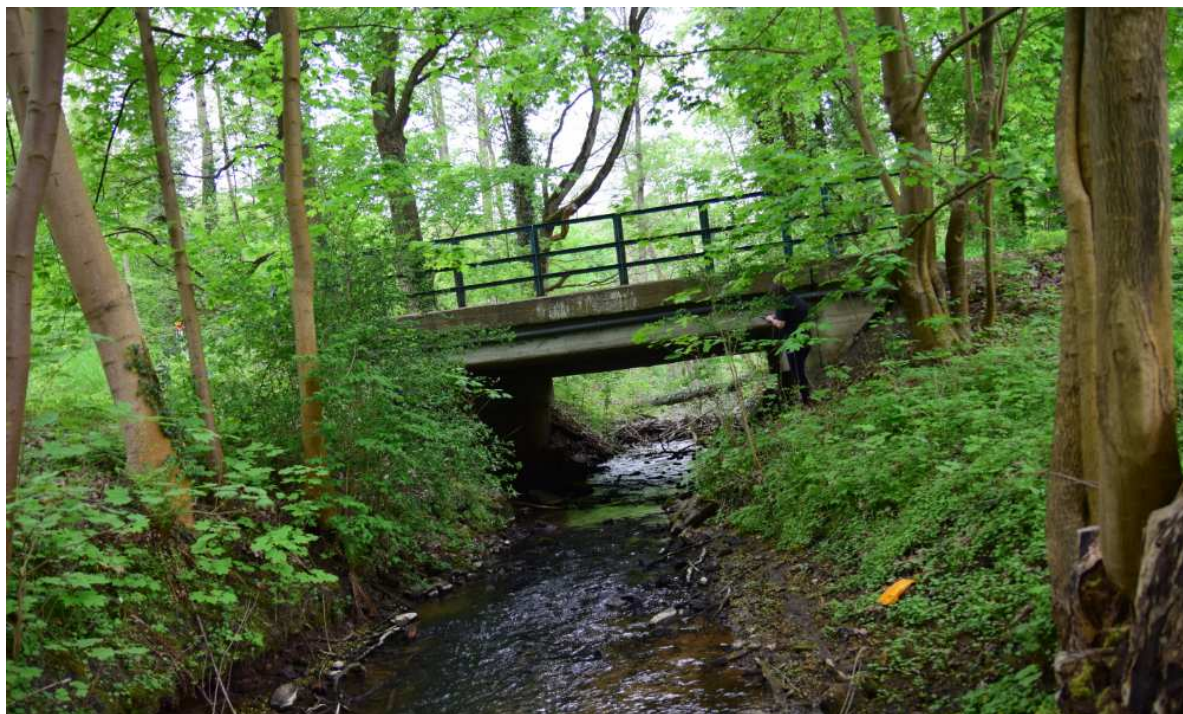
Rys. 3.2. Widok mostu od strony wody dolnej
