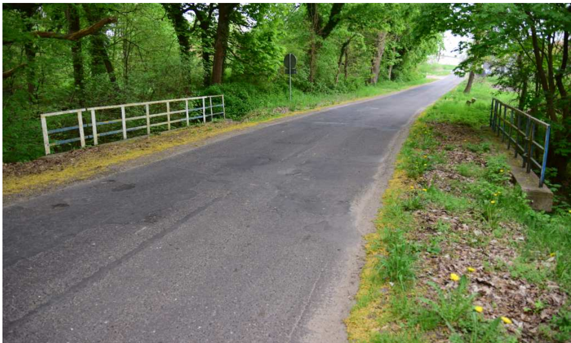
Rys. 3.4. Widok mostu z poziomu drogi
