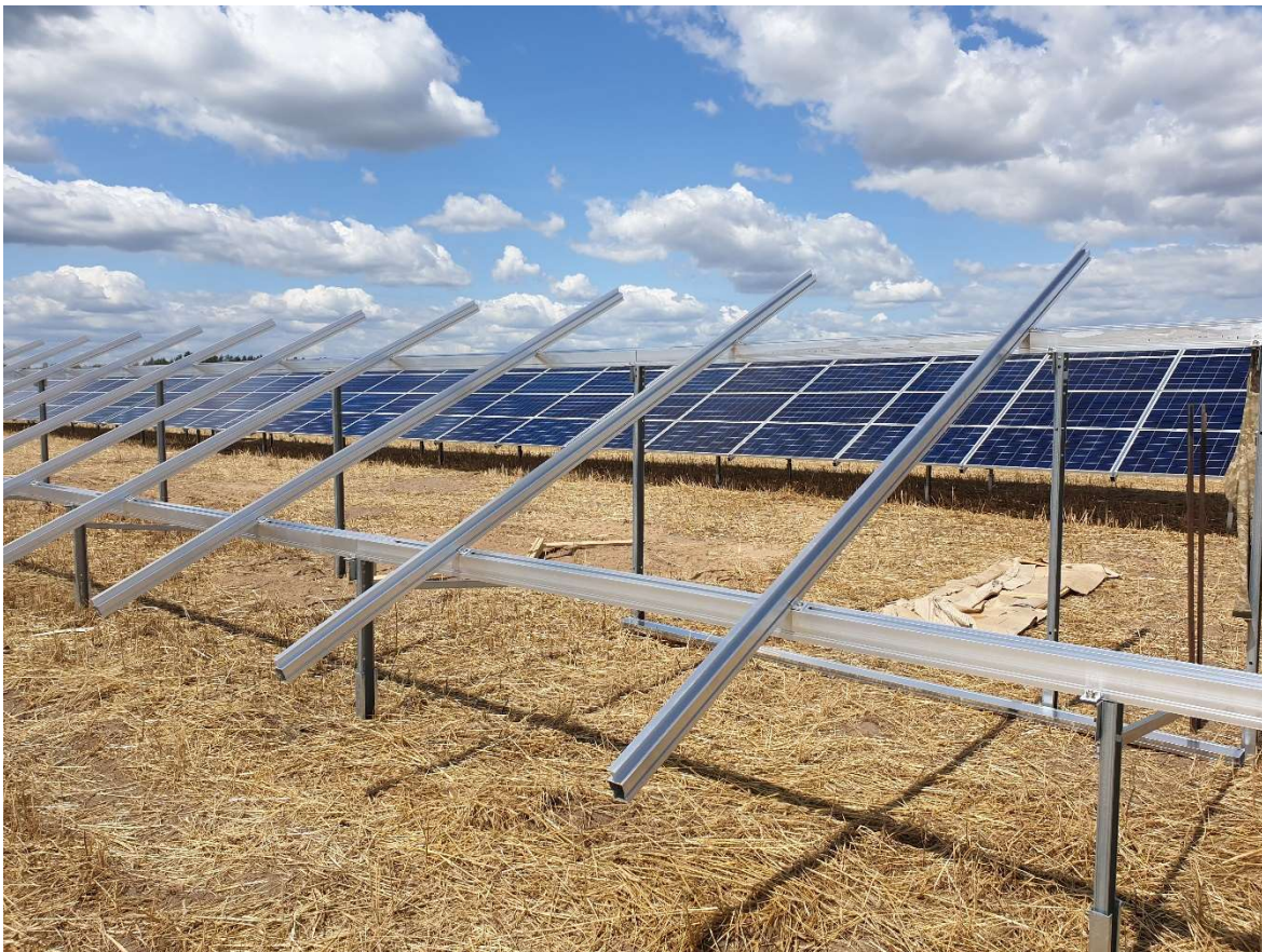
Fot. 1. Konstrukcja stołu z panelami fotowoltaicznymi.
