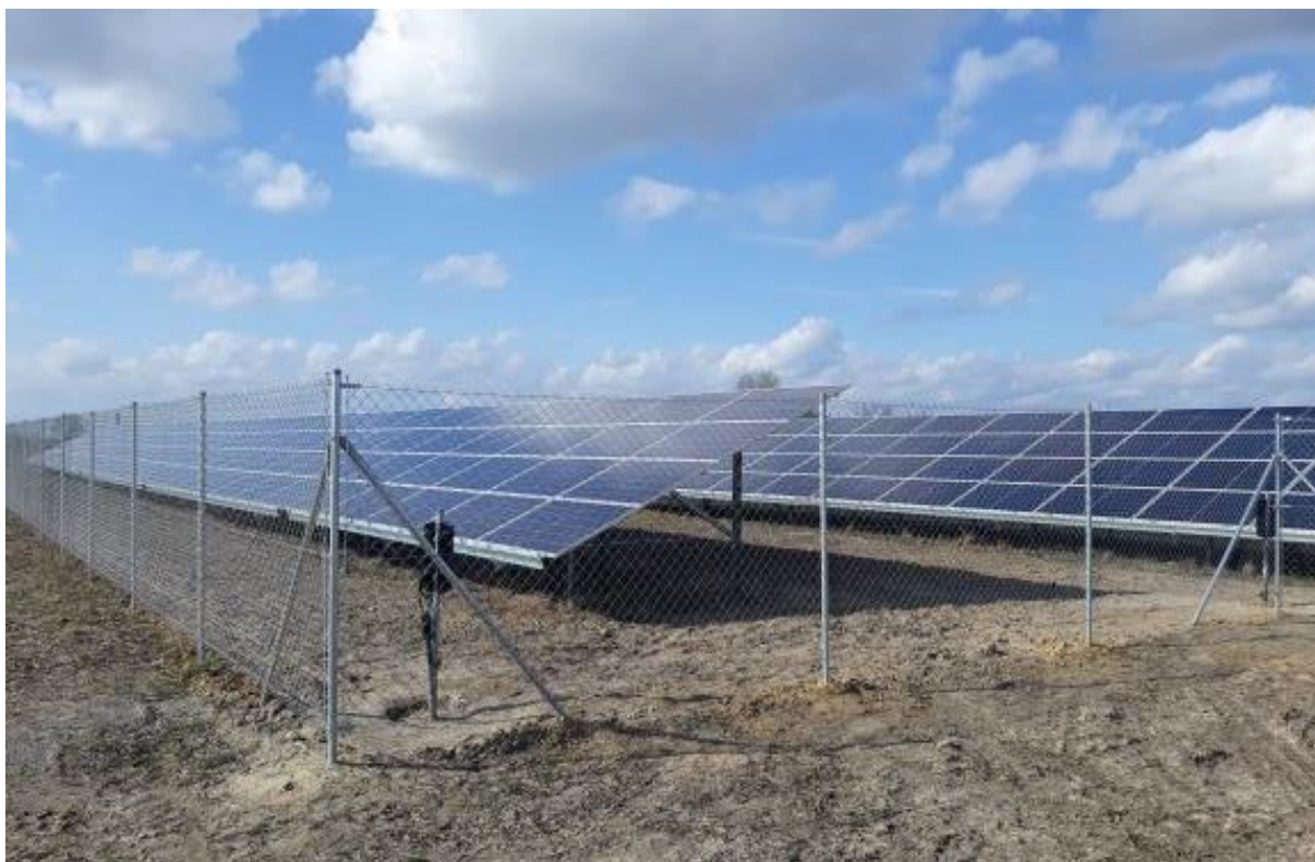
Rycina 9. Przykładowe ogrodzenie farmy fotowoltaicznej.
