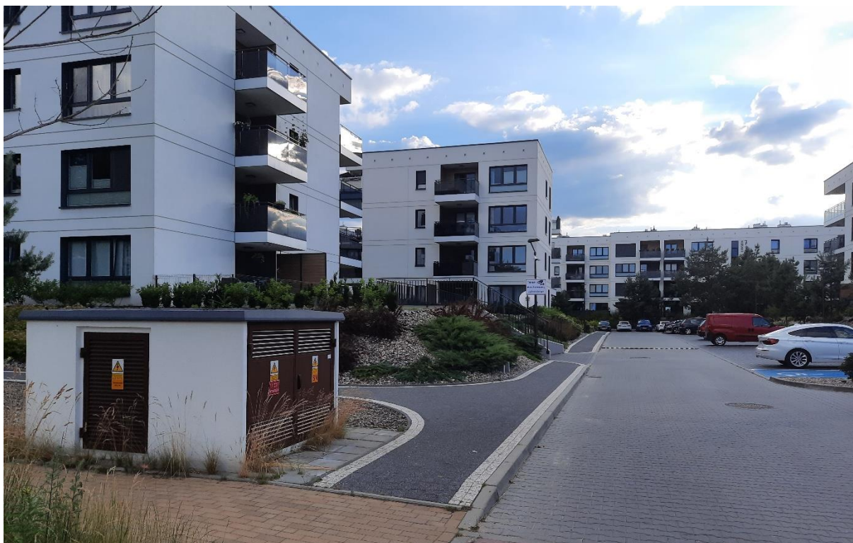
Rycina 10. Standardowa stacja kontenerowa w otoczeniu zabudowy.
