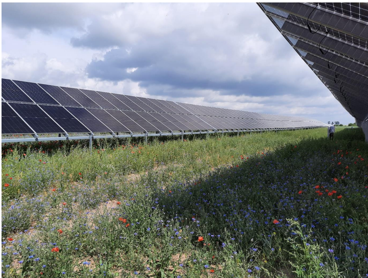
Rycina 1. Powierzchnia biologicznie czynna pod panelami fotowoltaicznymi.
