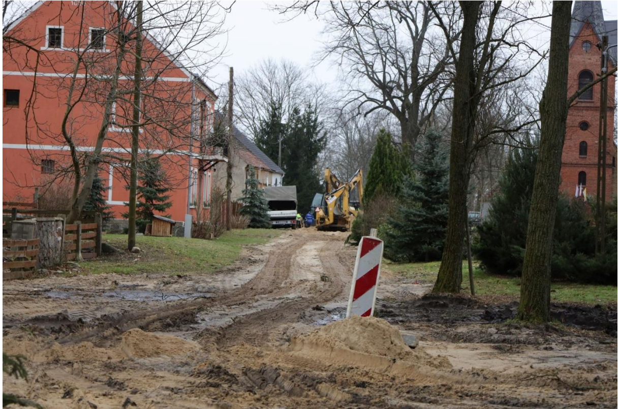
Budowa kanalizacji w m. Kęszycy
