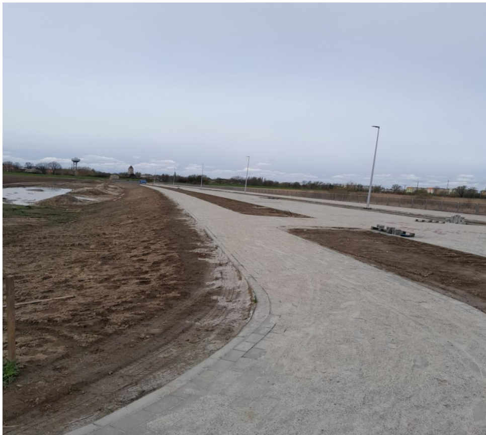
Budowa drogi – ulica Długa
