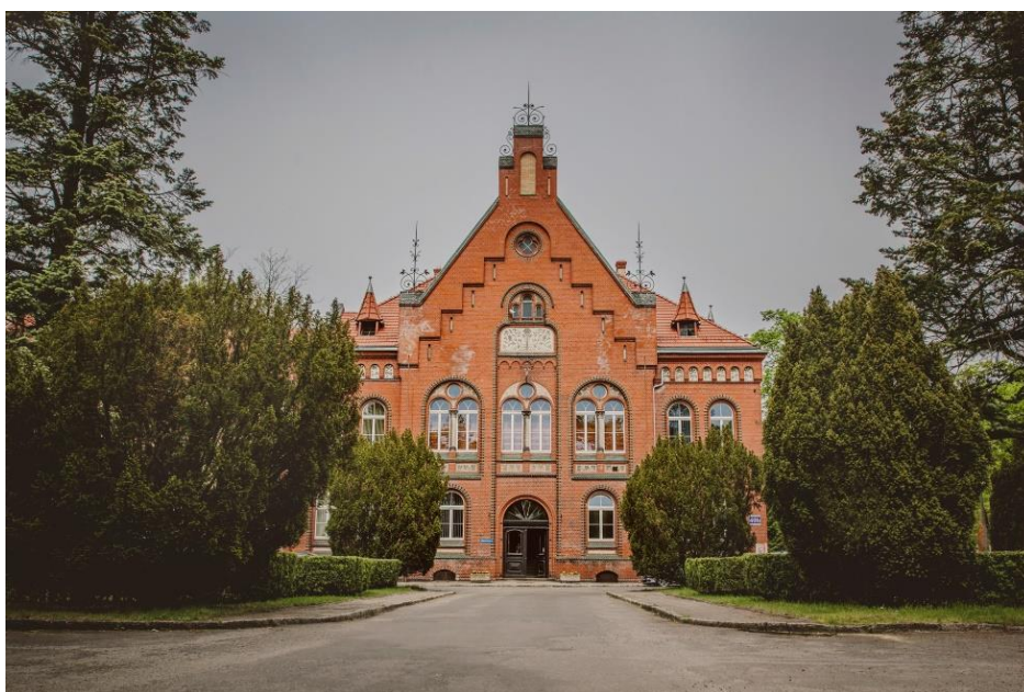
Budynek administracyjny szpitala w Obrzycach
