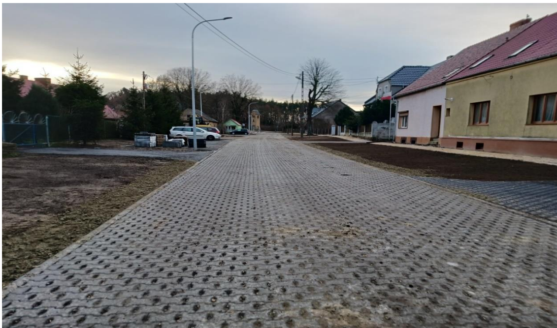
Przebudowa drogi w miejscowości Żółwin
