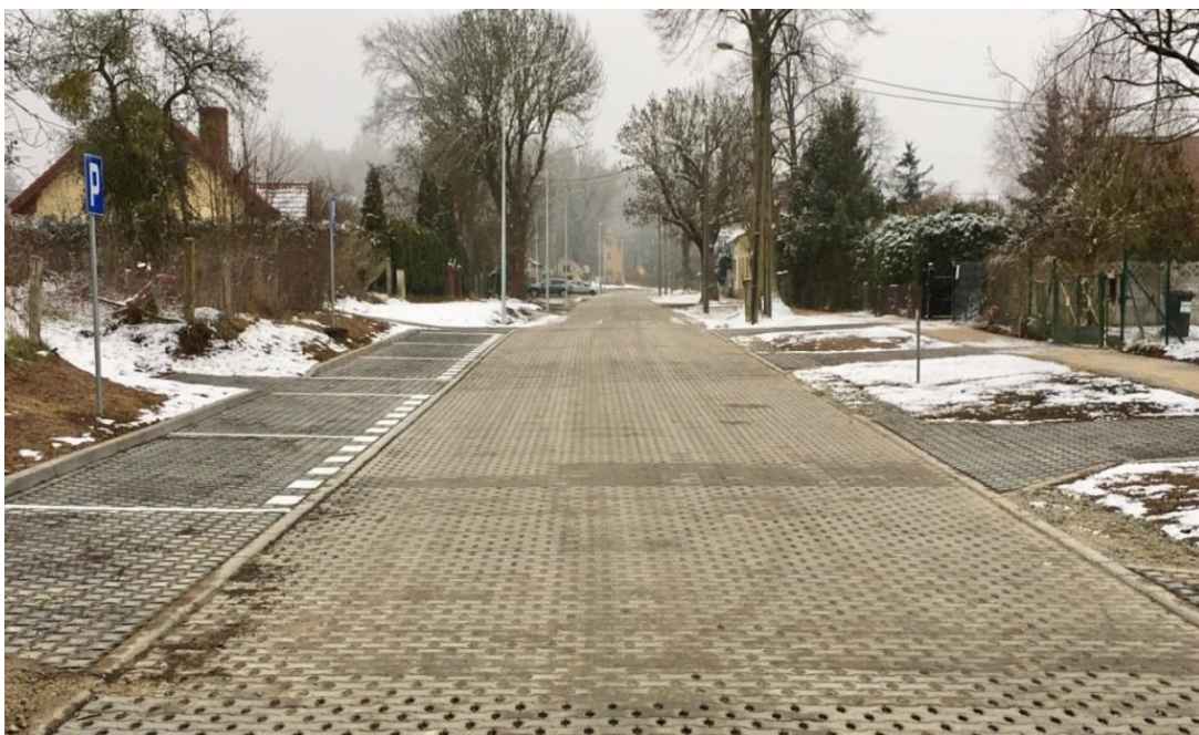
Przebudowa drogi w miejscowości Żółwin
