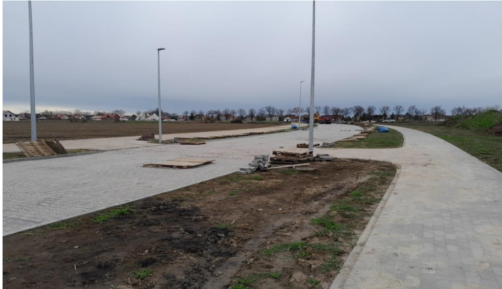
Budowa drogi – ulica Długa
