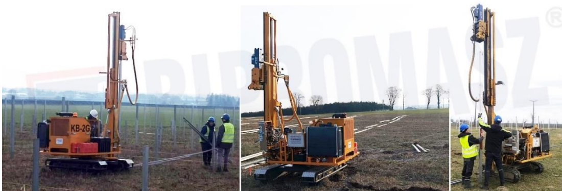
Rys. 7. Montaż profili za pomocą kafara (źródło: wiertnice.bipromasz.pl)
