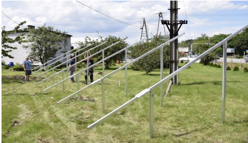
Rys. 6. Profile metalowe – podstawowy element konstrukcji (źródło: spomasz-konstrukcje.pl)
