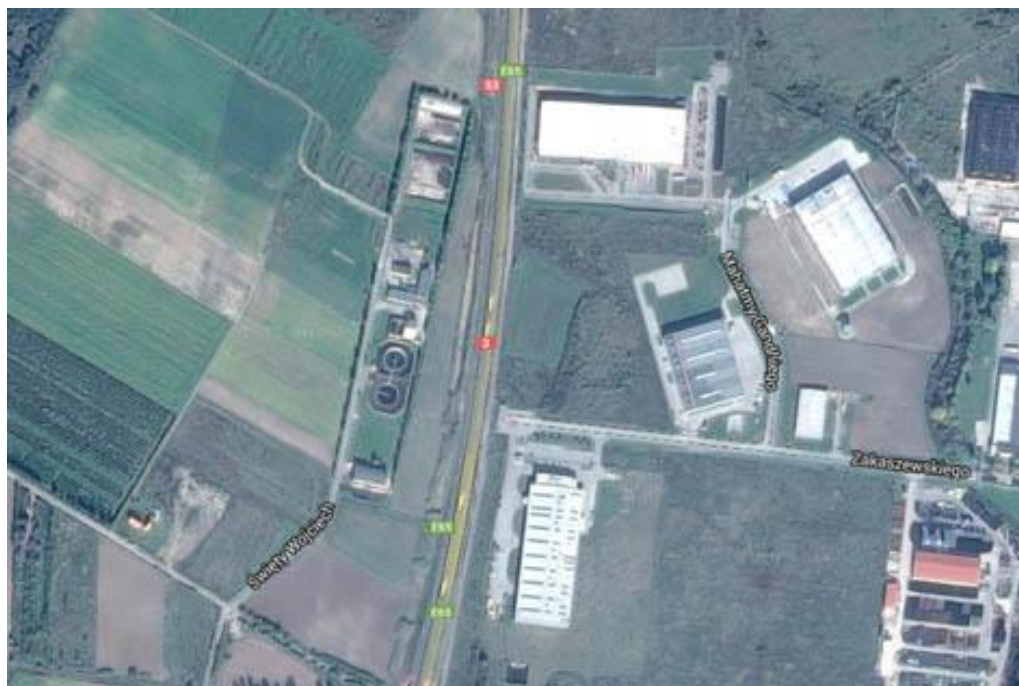
Fot. 1 Lokalizacja oczyszczalni ścieków w miejscowości Święty Wojciech
