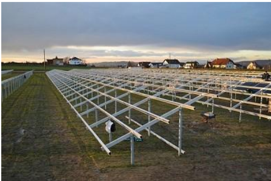
Rysunek 10: Szkielety przed montażem paneli, źródło: farma solarna NIENBURG 4 MW, Niemcy, Remor Solar.
