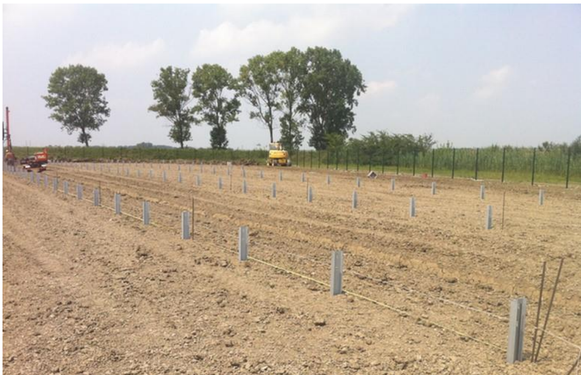
Rysunek 22 Profile nośne wbite w rodzimy grunt
