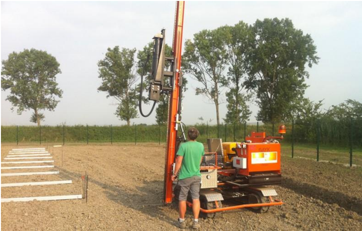
Rysunek 21 Katar do wbijania profili nośnych
