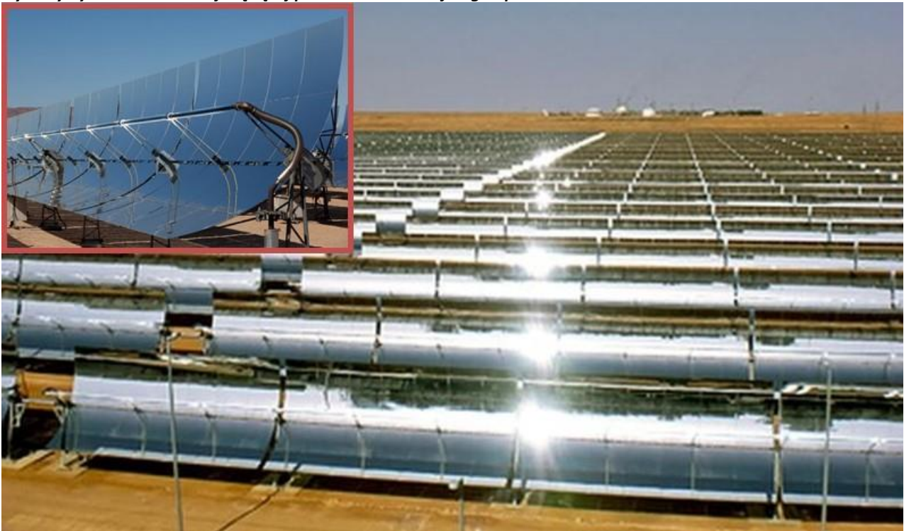
Rysunek 33 Lustrzane panele słoneczne (koncentratory)
