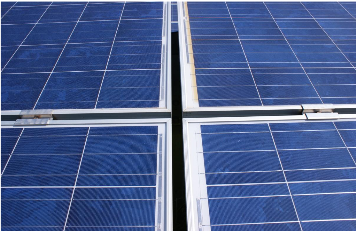
Rysunek 12 Sposób łączenia paneli fotowoltaicznych
