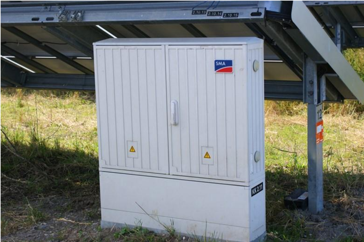
Rysunek 15 String-box mocowany na gruncie
