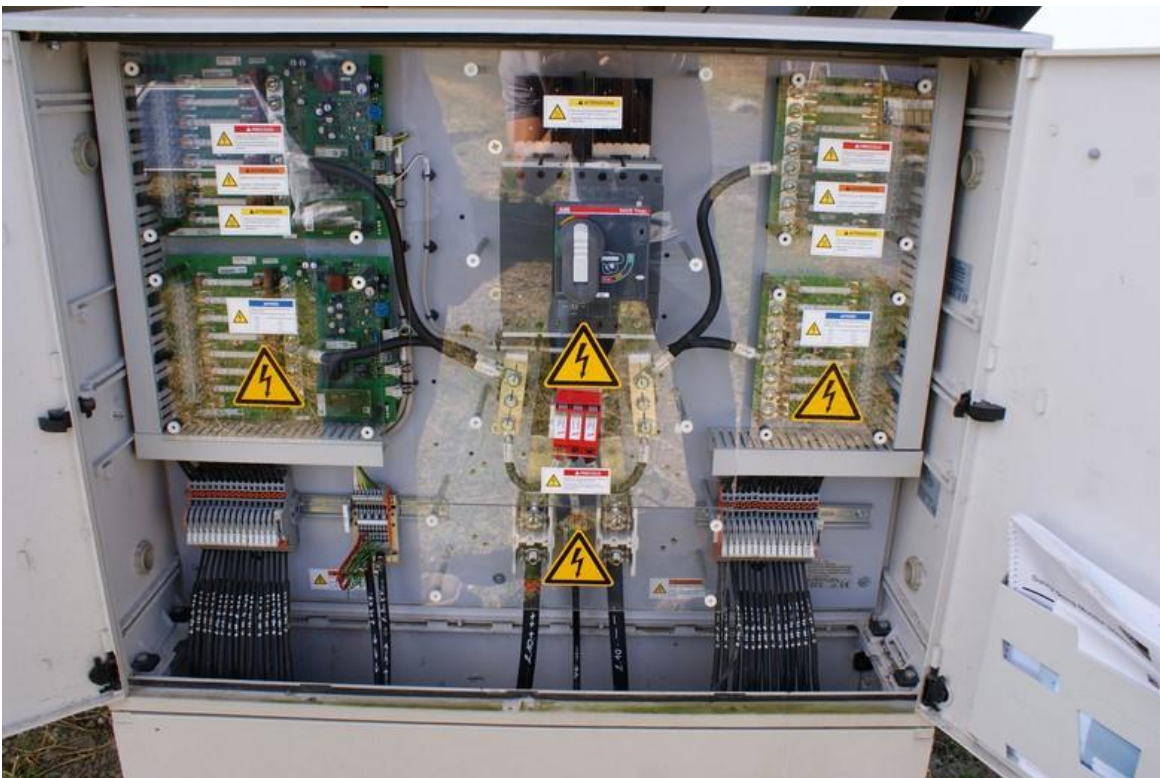
Rysunek 16 Wnętrze string-box`a
