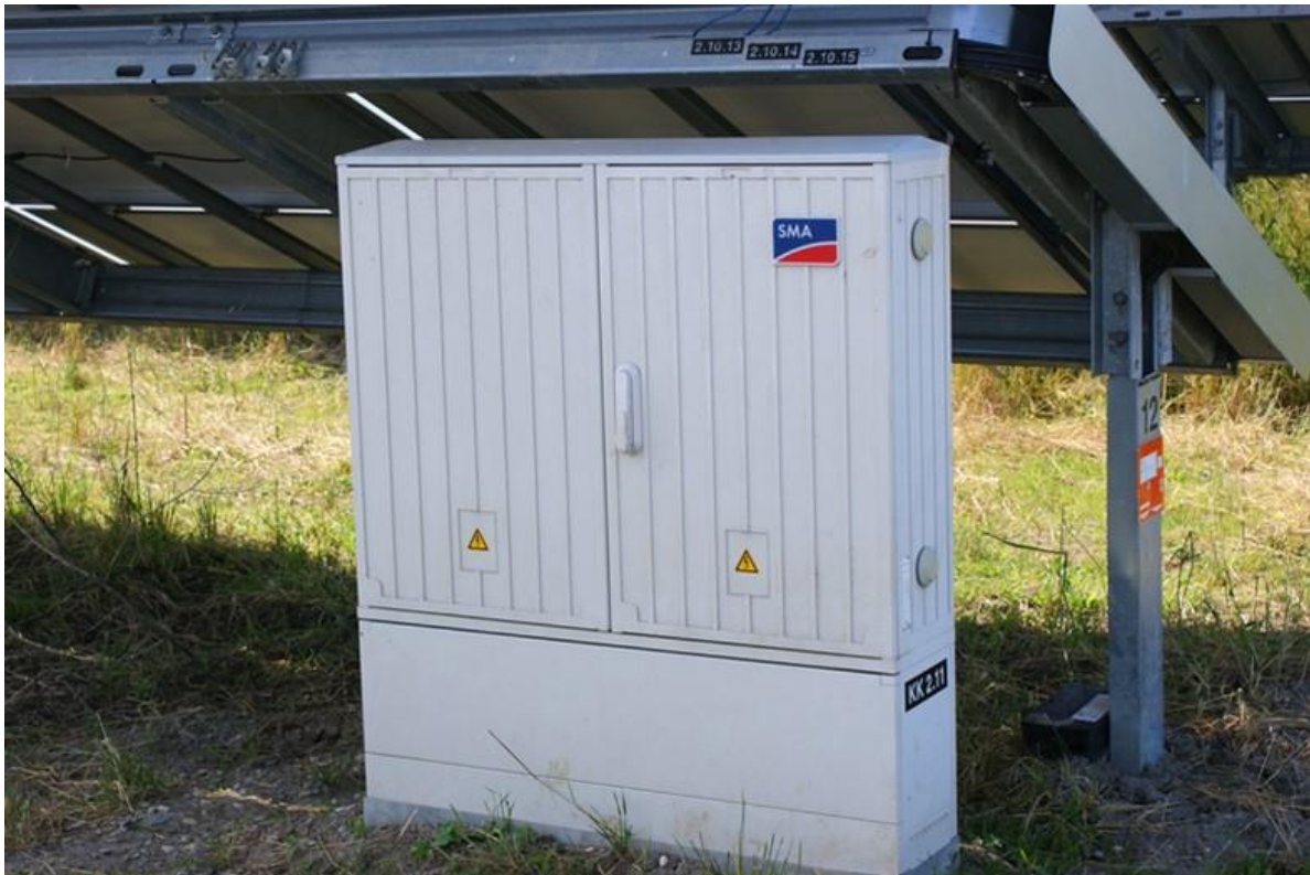
Rysunek 15 String-box mocowany na gruncie
