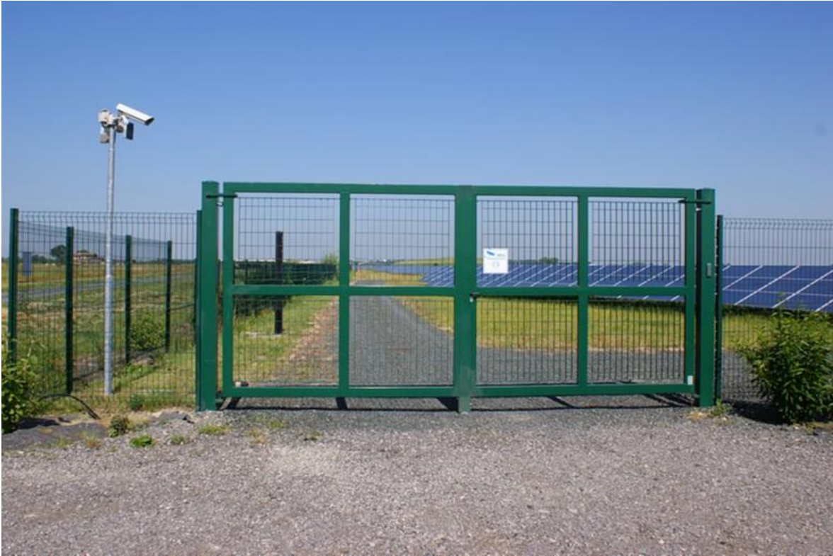
Rysunek 19 Brama wjazdowa oraz system monitoringu
