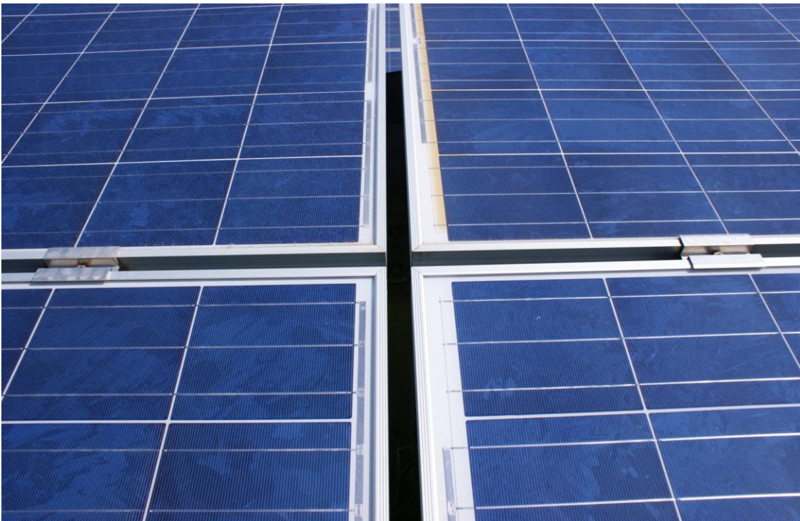
Rysunek 12 Sposób łączenia paneli fotowoltaicznych
