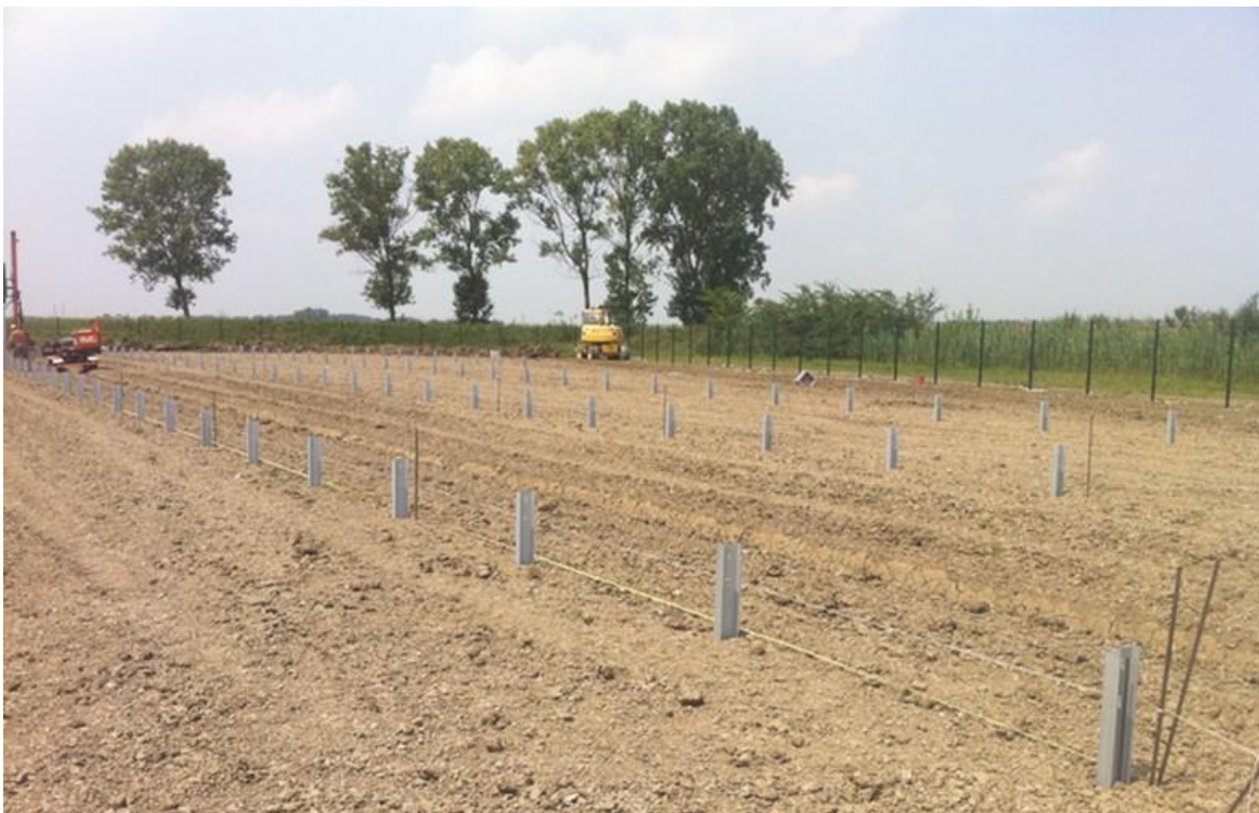
Rysunek 22 Profile nośne wbite w rodzimy grunt
