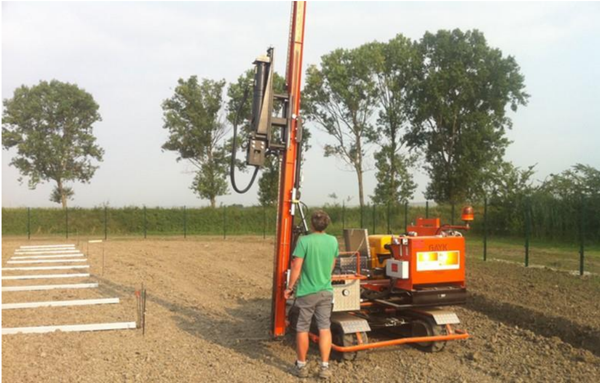
Rysunek 21 Kafar do wbijania profili nośnych
