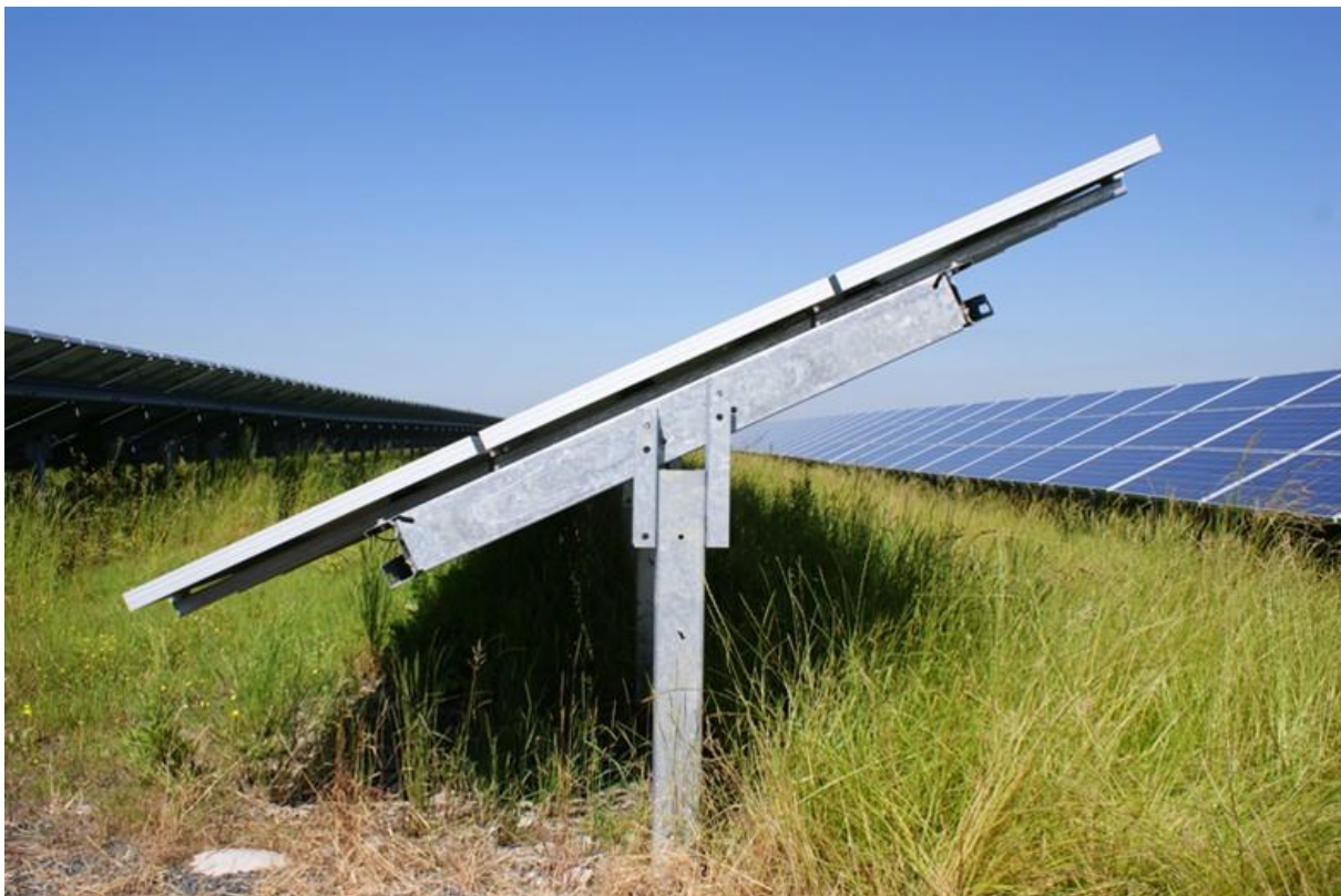
Rysunek 13 Konstrukcja wsporcza oparta na pojedynczych profilach wbitych bezpośrednio w grunt
