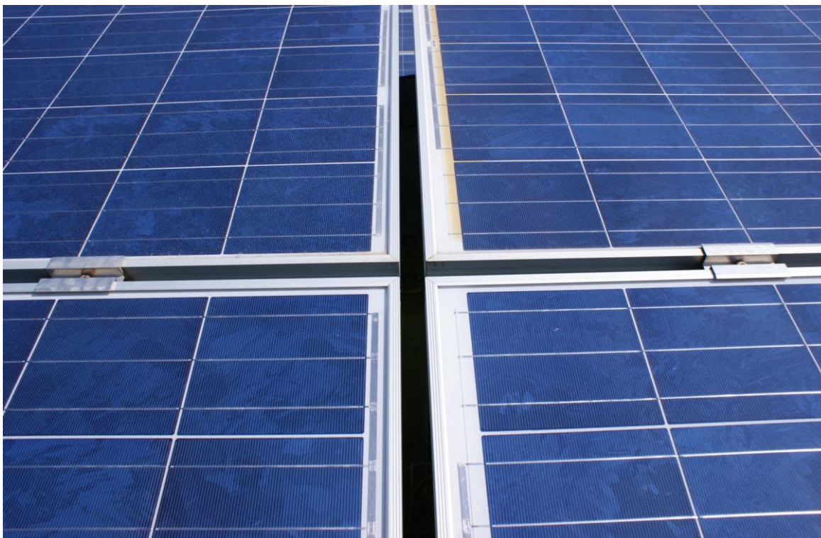
Rysunek 12 Sposób łączenia paneli fotowoltaicznych
