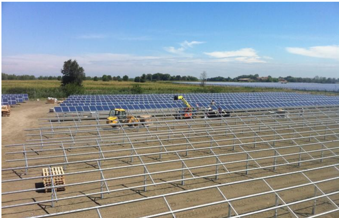
Rysunek 25 Proces montażu modułów fotowoltaicznych na konstrukcji szkieletowej
