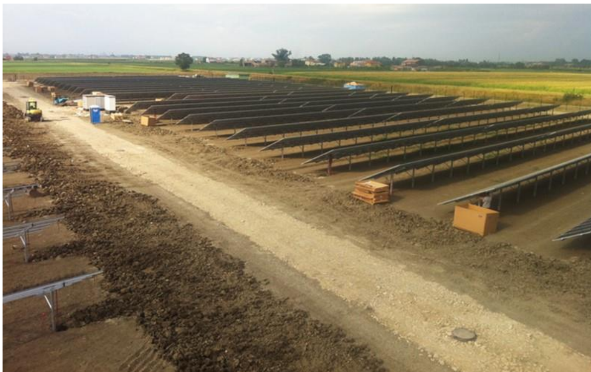
Rysunek 26 Farma na jednym z ostatnich etapów budowy, po montażu modułów i zasypaniu przewodów
