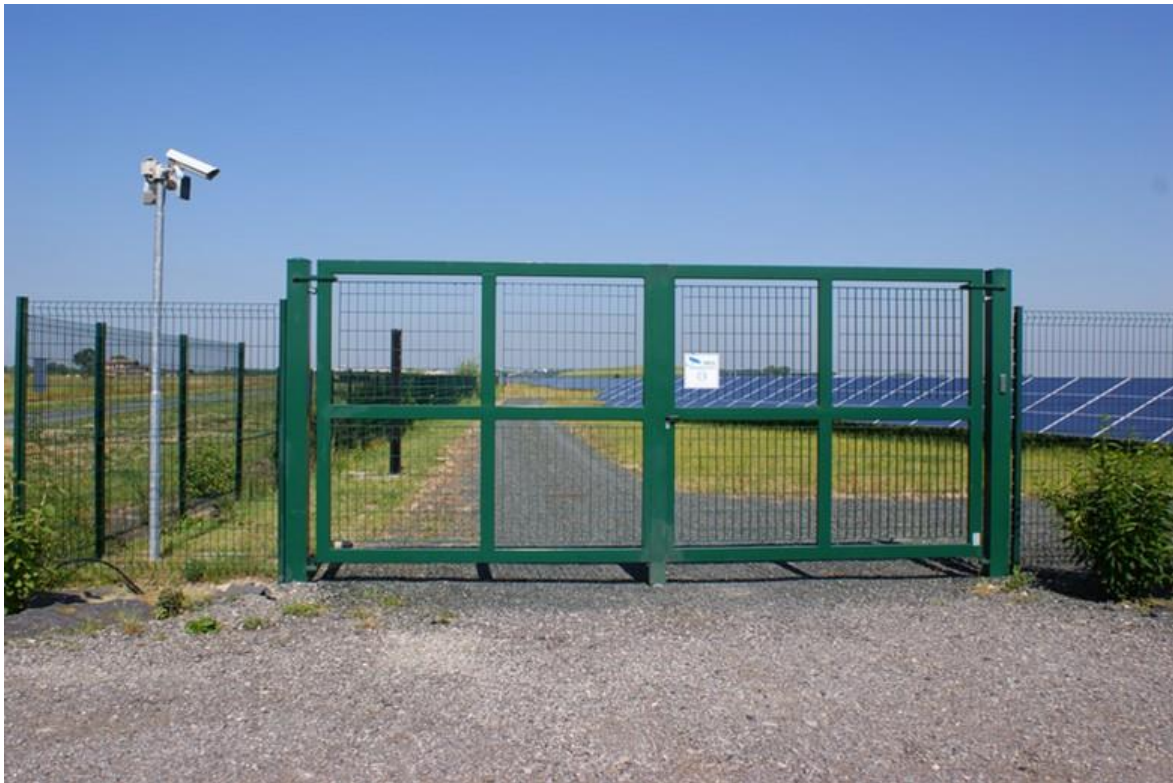
Rysunek 19 Brama wjazdowa oraz system monitoringu
