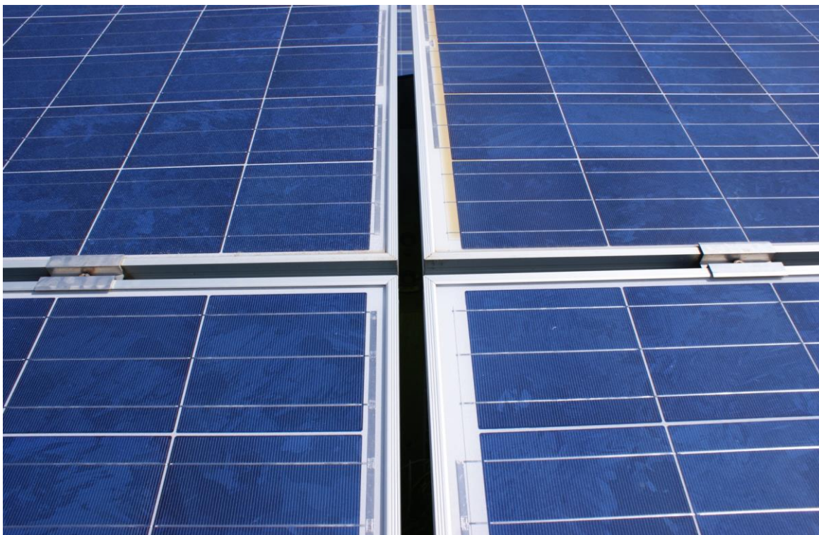
Rysunek 12 Sposób łączenia paneli fotowoltaicznych
