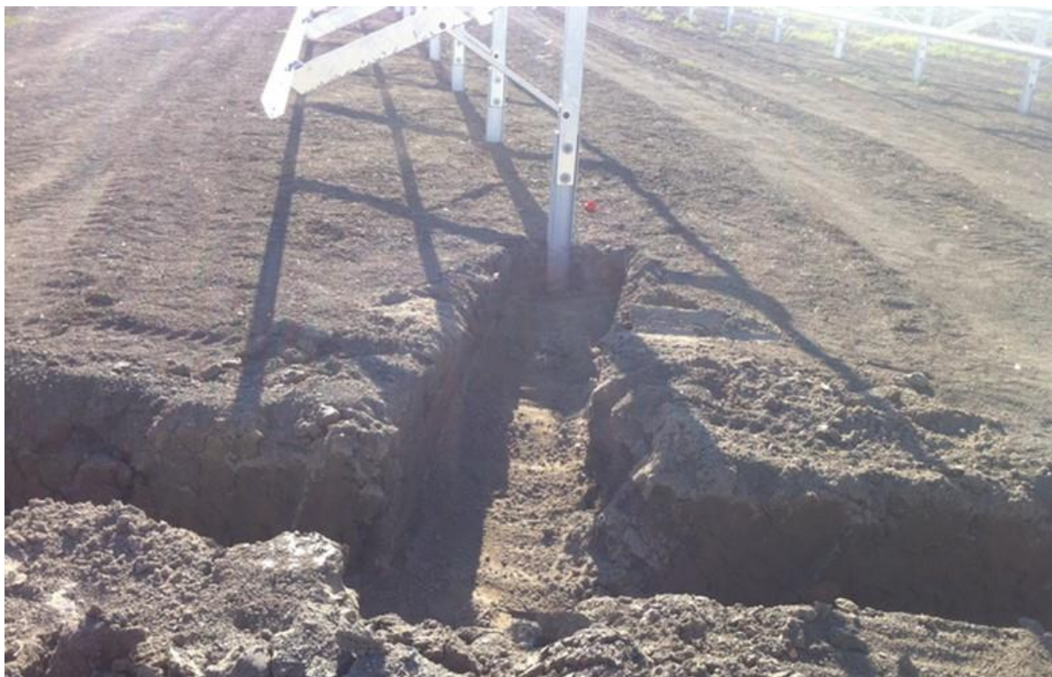
Rysunek 23 Skręcona konstrukcja nona modułów oraz otworzony wykop pod przewody elektryczne
