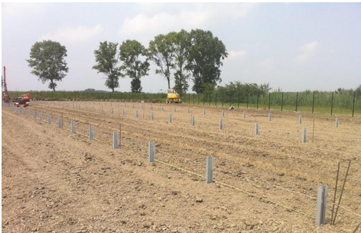
Rysunek 22 Profile nośne wbite w rodzimy grunt
