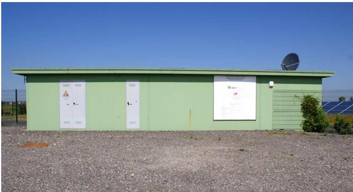
Rysunek 18 Budynek techniczny widziany od zewnętrznej strony ogrodzenia
