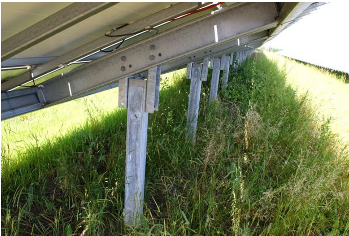
Rysunek 14 Sposób łączenia szkieletu-podstawy modułów fotowoltaicznych z profilami
