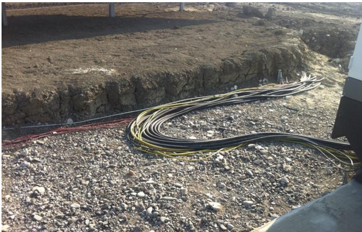
Rysunek 24 Przewody ułożone w wykopie – z prawej strony widoczny fragment płyty fundamentowej oraz sam obiekt inwertera
