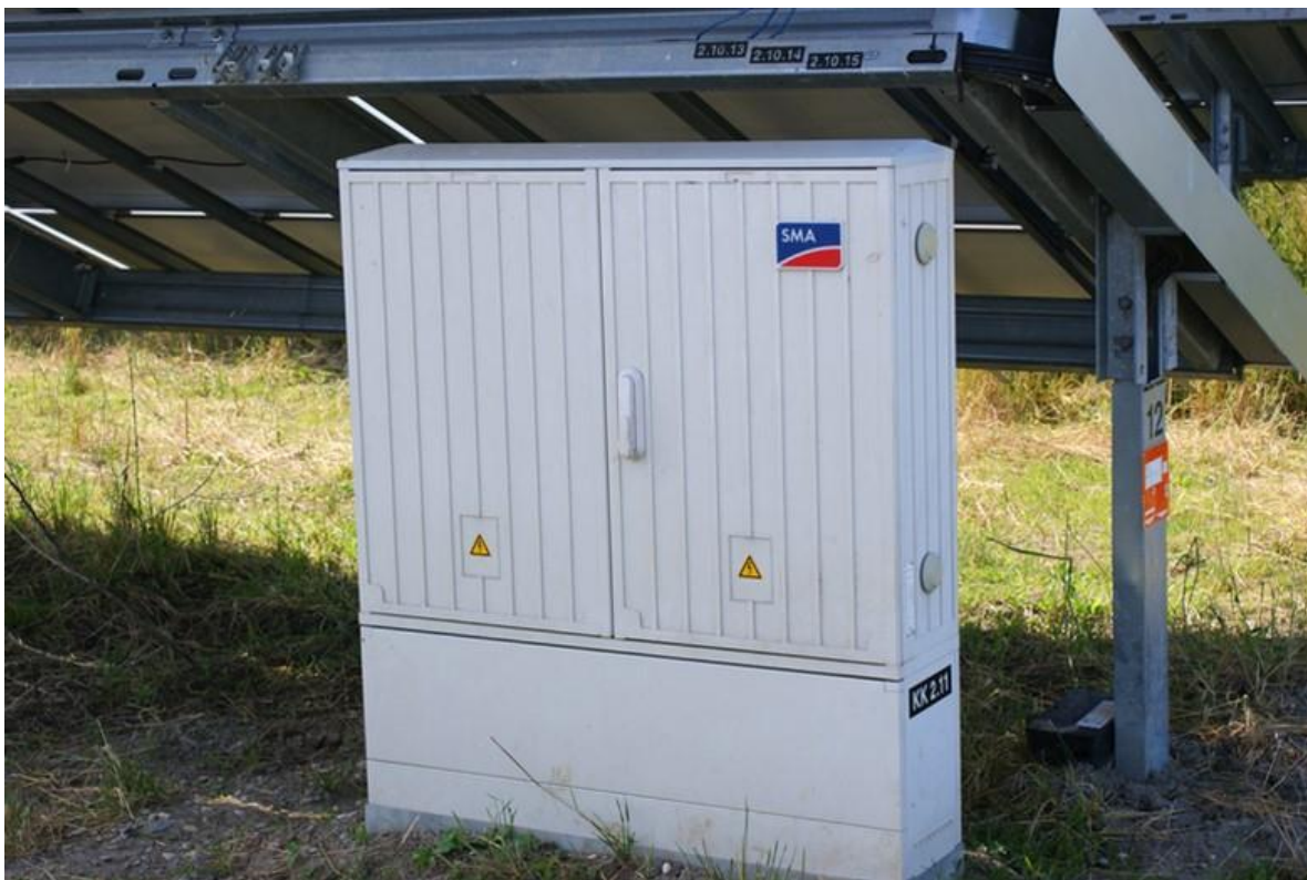
Rysunek 15 String-box mocowany na gruncie
