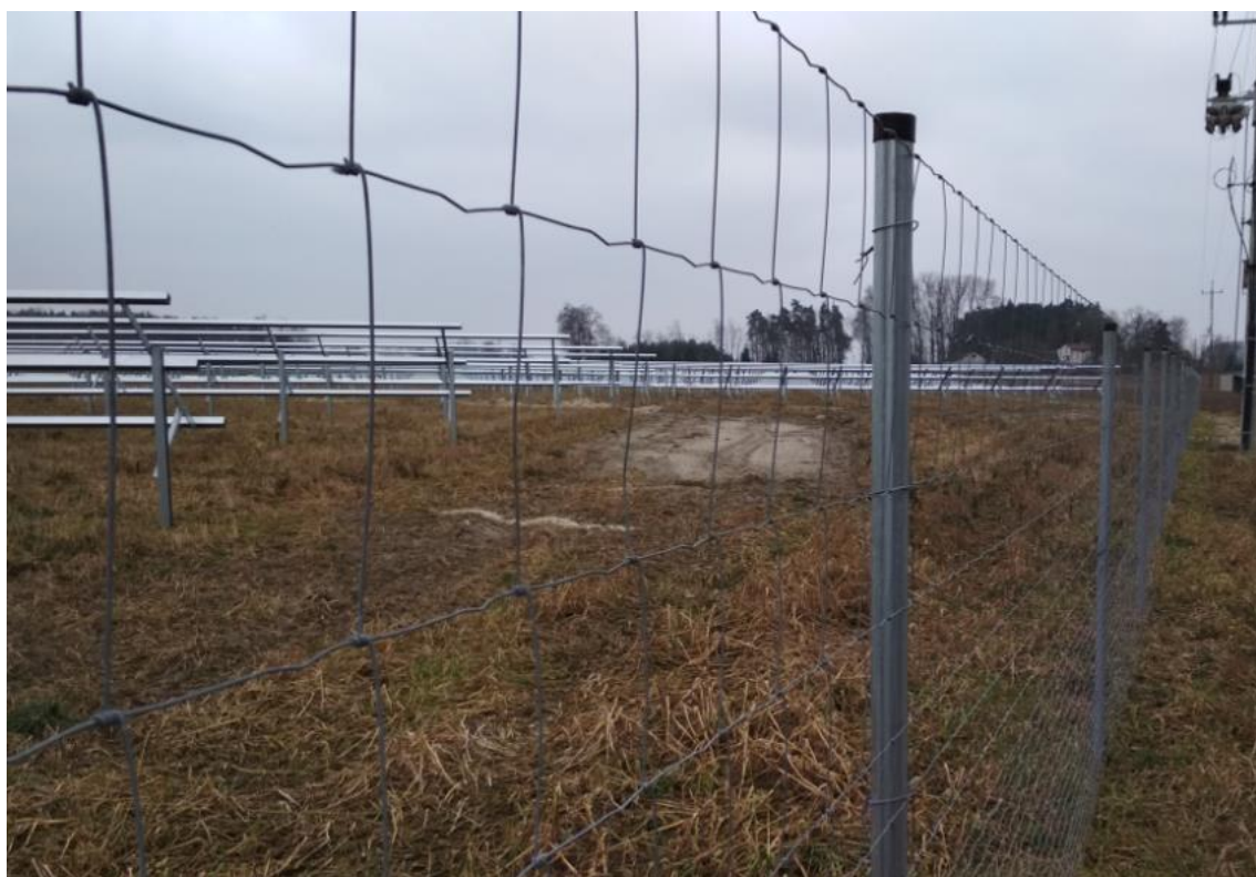
FOTOGRAFIA 7. Widok na przykładowe ogrodzenie dla instalacji, o ustalonej szerokości oczek w siatce [foto: Paweł Kręciproch; instalacja w miejscowości Poddębice]
