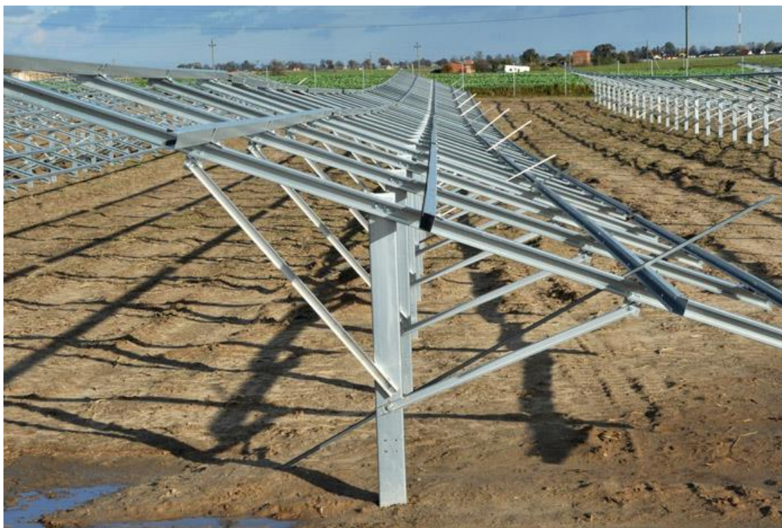
Rysunek 15 Sposób łączenia szkieletu-podstawy modułów fotowoltaicznych z profilami z wykorzystaniem zastrzałów
