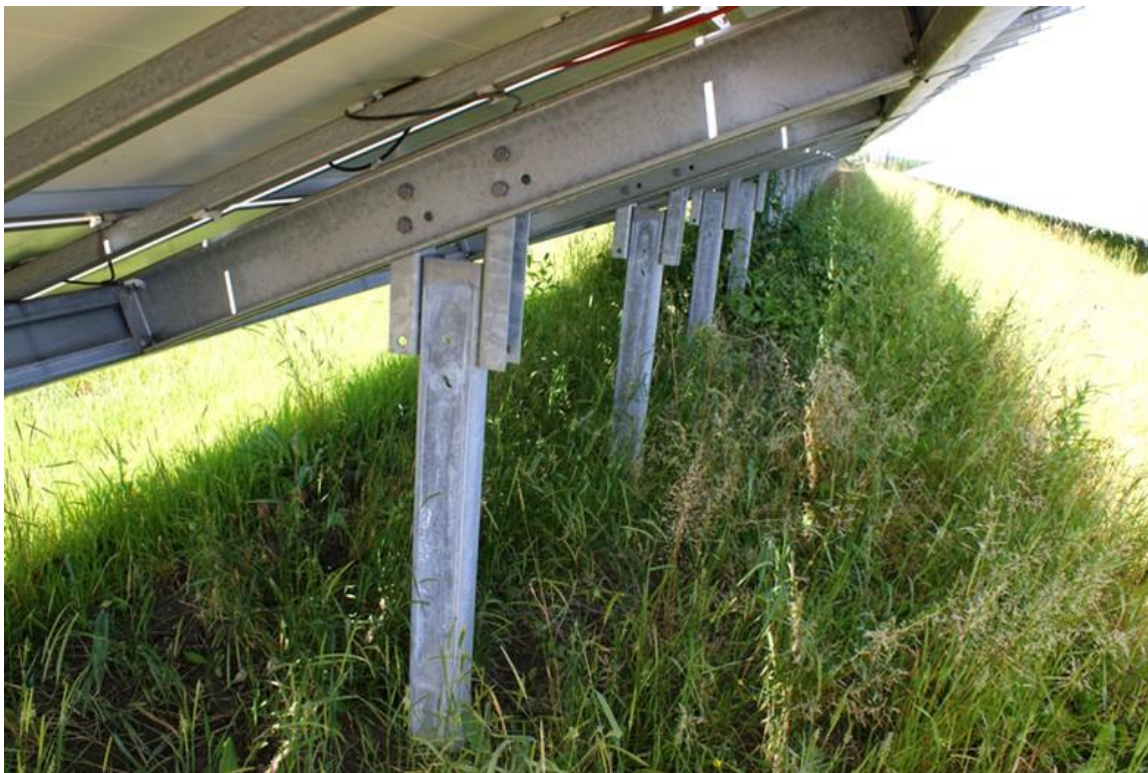
Rysunek 12 Sposób łączenia szkieletu-podstawy modułów fotowoltaicznych z profilami
