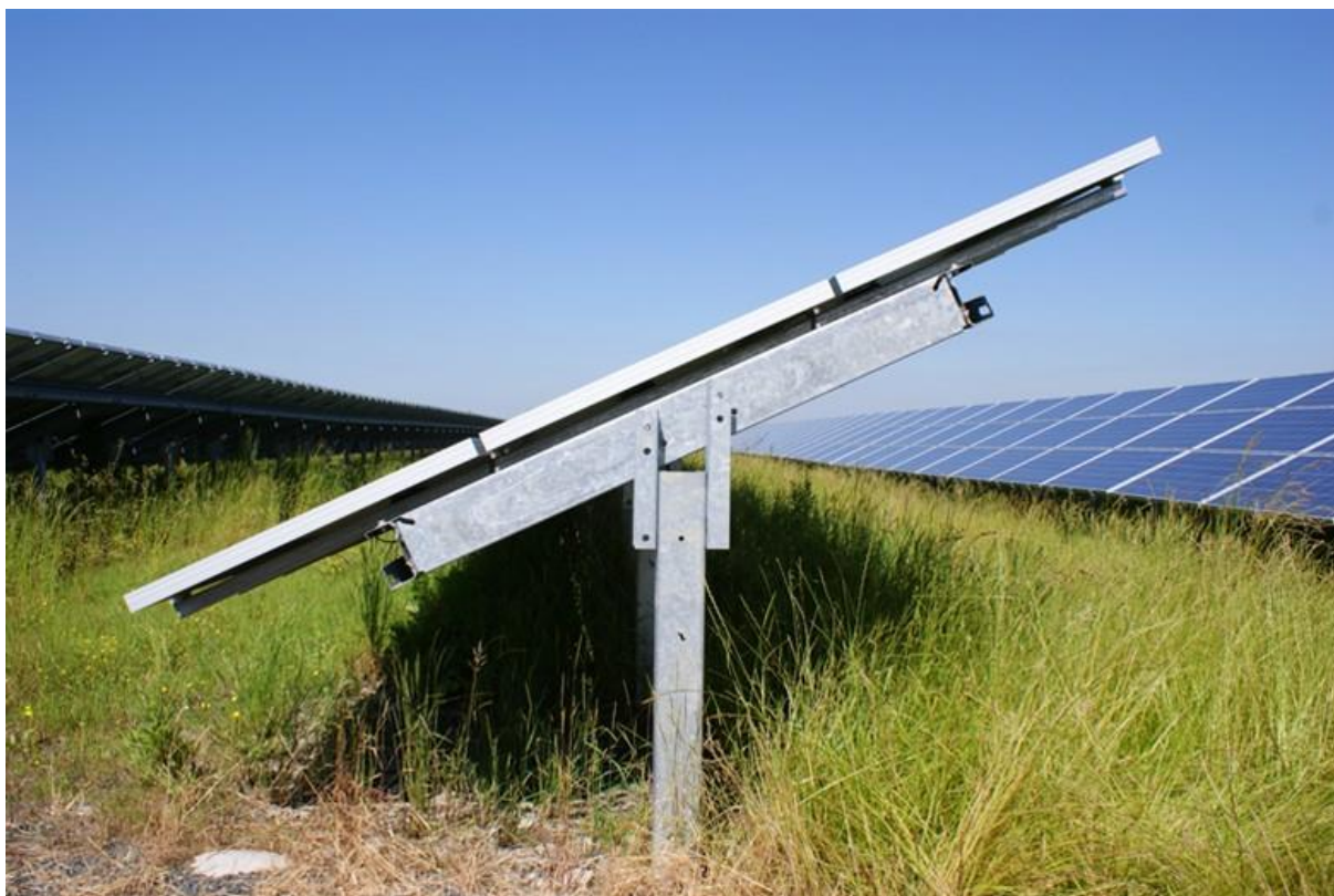
Rysunek 11 Konstrukcja wsporcza oparta na pojedynczych profilach wbitych bezpośrednio w grunt
