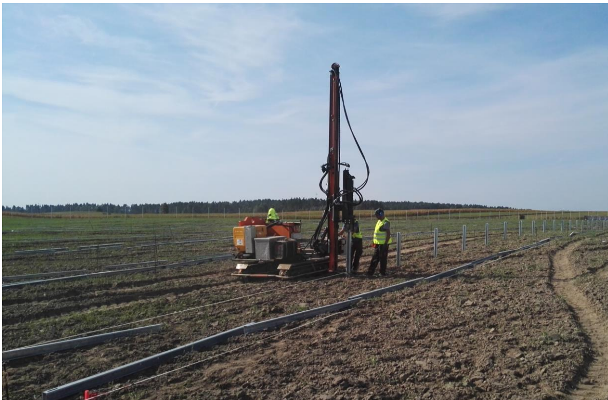
Rysunek 24 Kafar do wbijania profili nośnych
