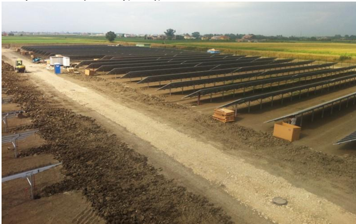
Rysunek 29 Farma na jednym z ostatnich etapów budowy, po montażu modułów i zasypaniu przewodów
