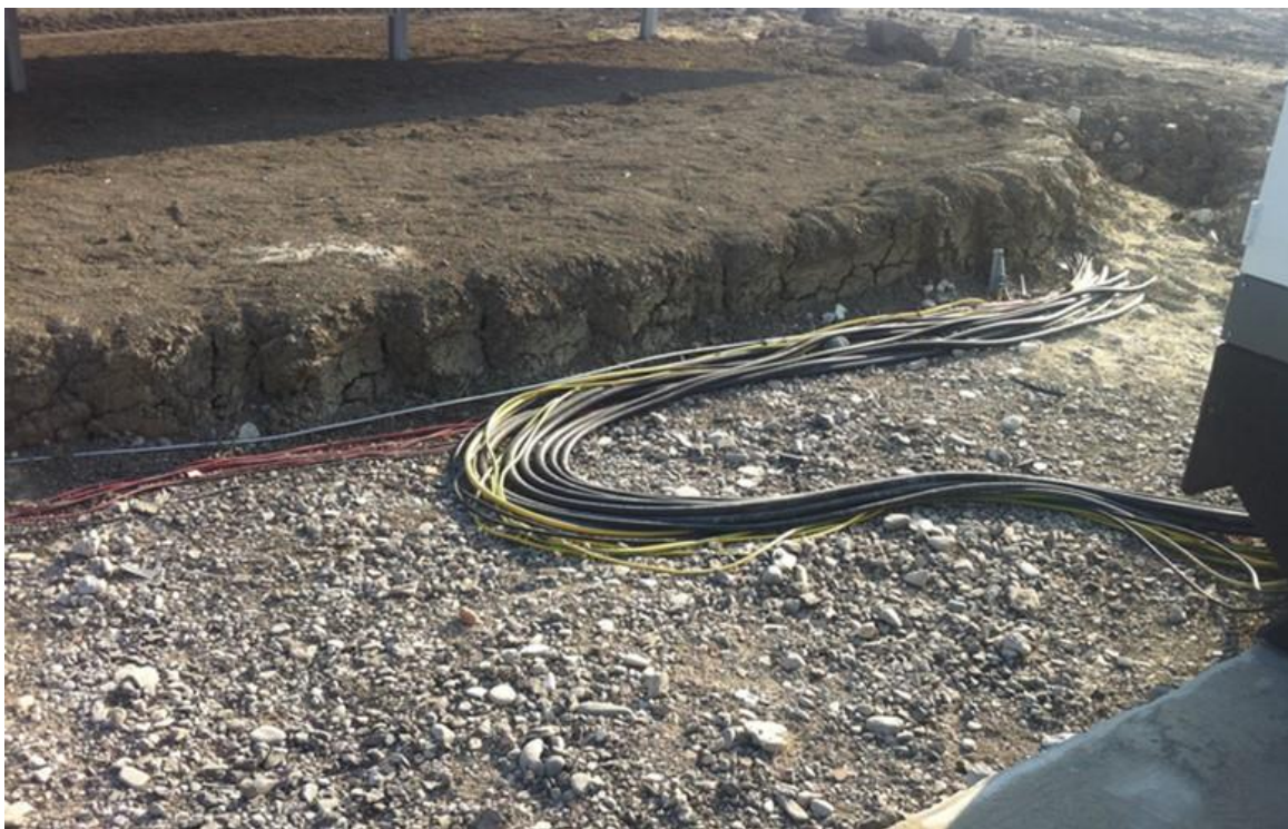
Rysunek 27 Przewody ułożone w wykopie – z prawej strony widoczny fragment płyty fundamentowej oraz sam obiekt inwertera
