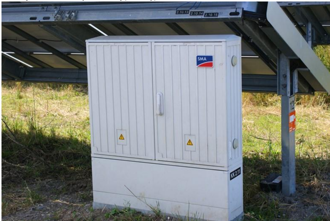
Rysunek 16 String-box mocowany na gruncie
