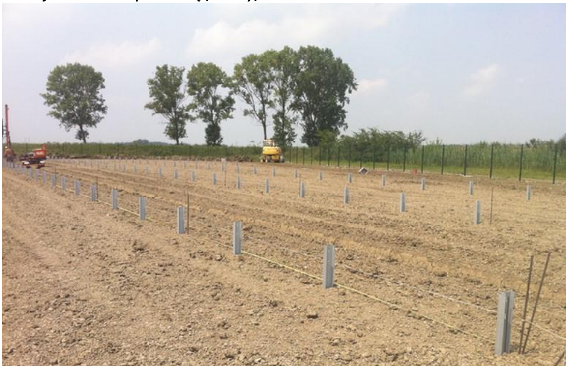
Rysunek 25 Profile nośne wbite w rodzimy grunt
