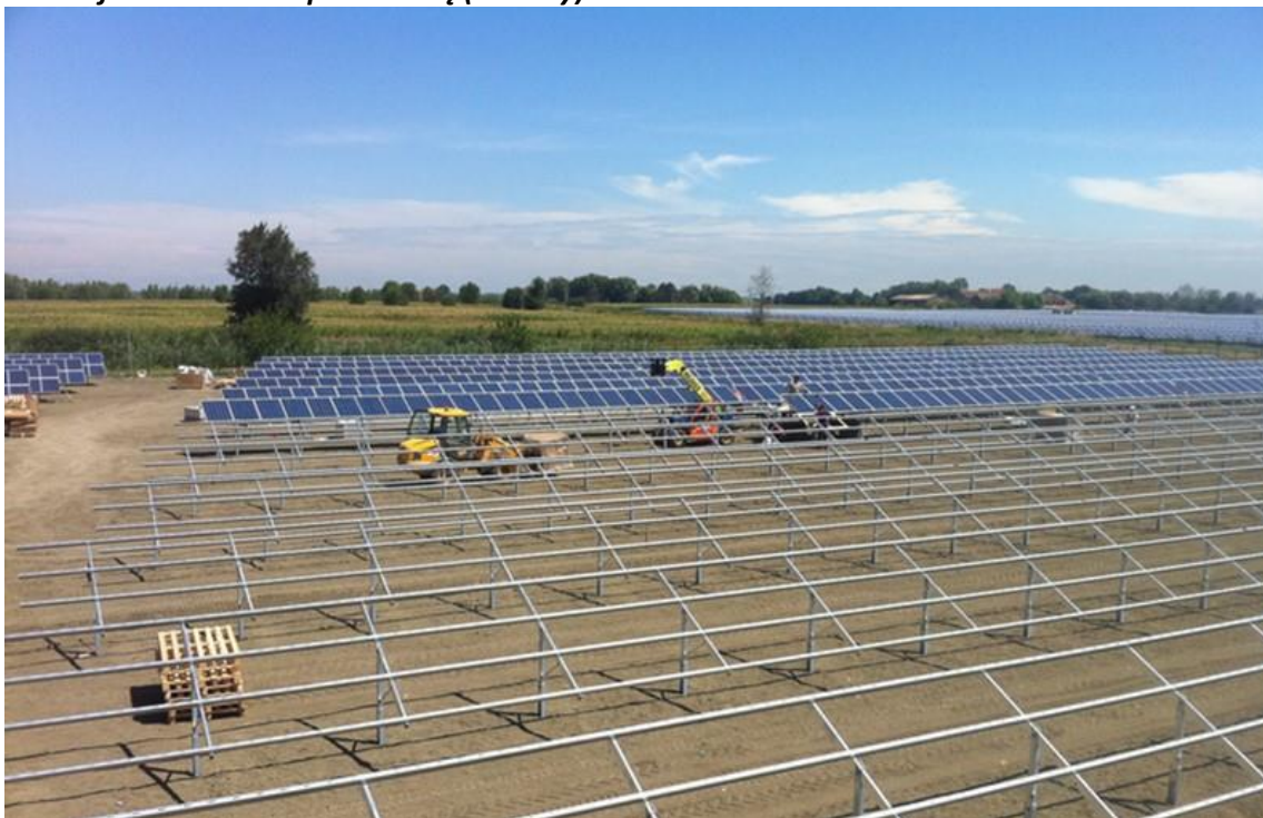
Rysunek 28 Proces montażu modułów fotowoltaicznych na konstrukcji szkieletowej
