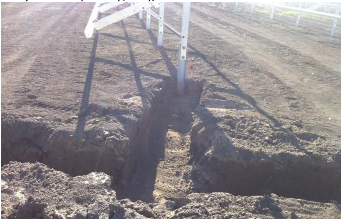
Rysunek 26 Skręcona konstrukcja nona modułów oraz otworzony wykop pod przewody elektryczne
