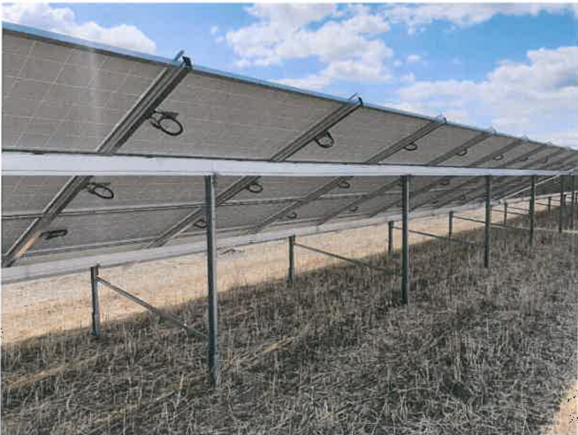
Fot. 3. Sposób montażu paneli fotowoltaicznych na stelażach wbijanych bezpośrednio do gruntu.
