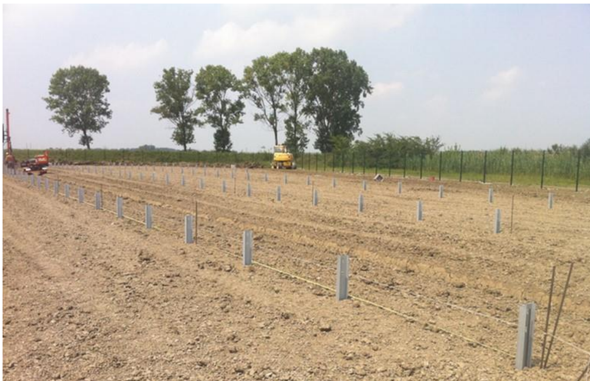
Rysunek 20 Profile nośne wbite w rodzimy grunt
