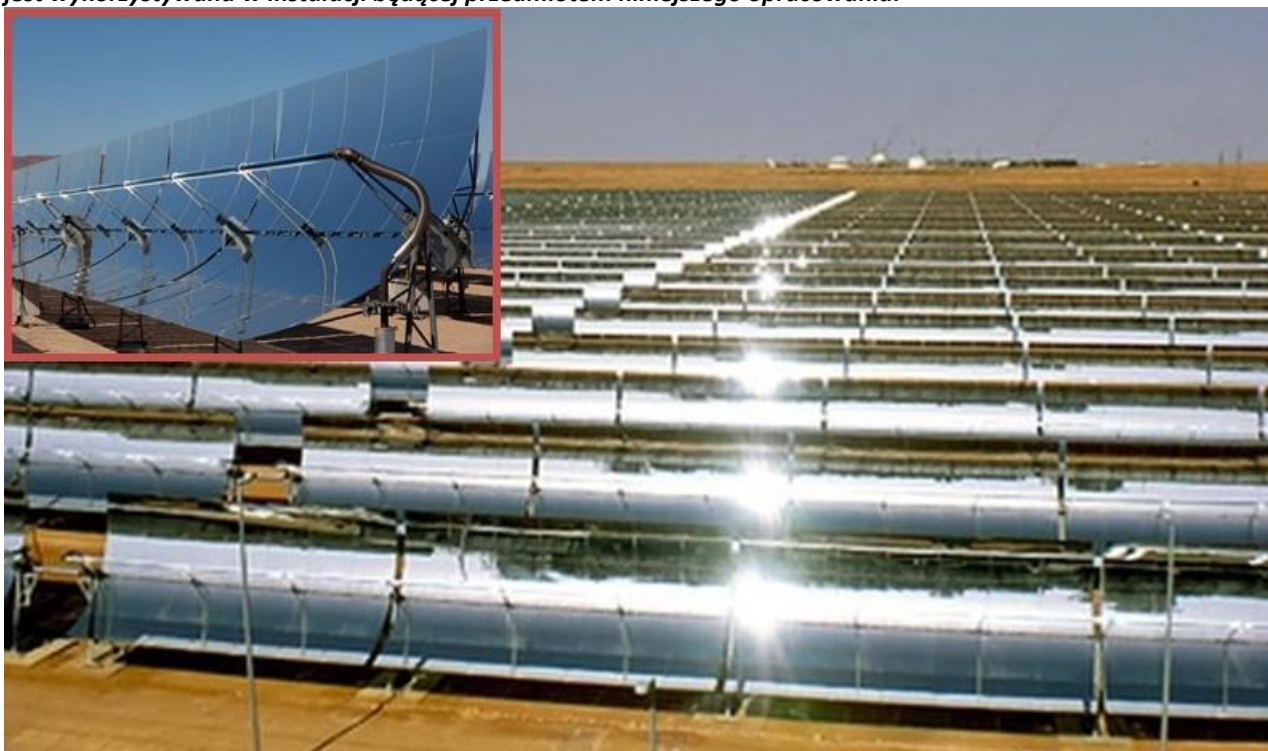
Rysunek 31 Lustrzane panele słoneczne (koncentratory)
