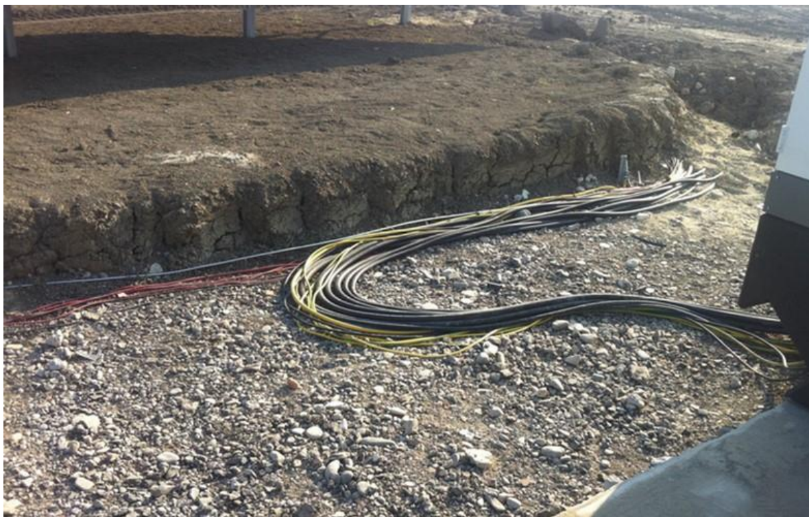
Rysunek 22 Przewody ułożone w wykopie – z prawej strony widoczny fragment płyty fundamentowej oraz sam obiekt inwertera Źródło: Archiwum własne
