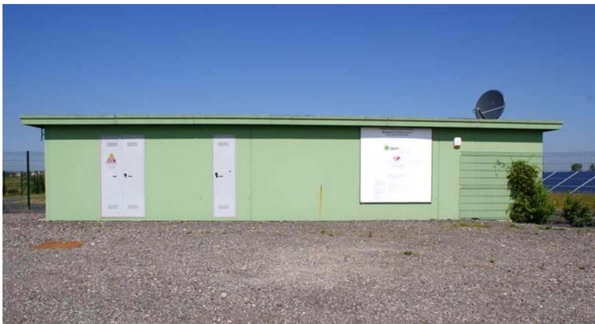
Rysunek 16 Budynek techniczny widziany od zewnętrznej strony ogrodzenia Źródło: Archiwum własne
