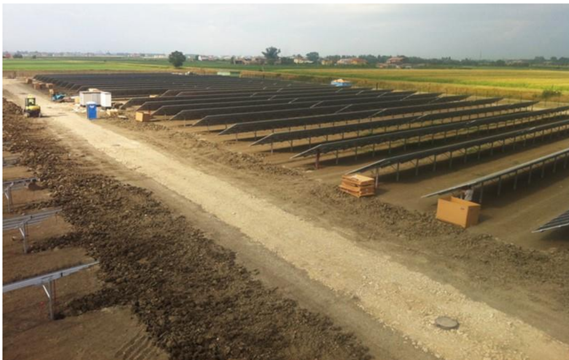
Rysunek 24 Farma na jednym z ostatnich etapów budowy, po montażu modułów i zasypaniu przewodów
