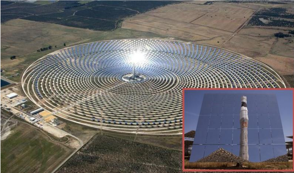
Rysunek 32 Farma słoneczna wykorzystująca wieżę słoneczną
