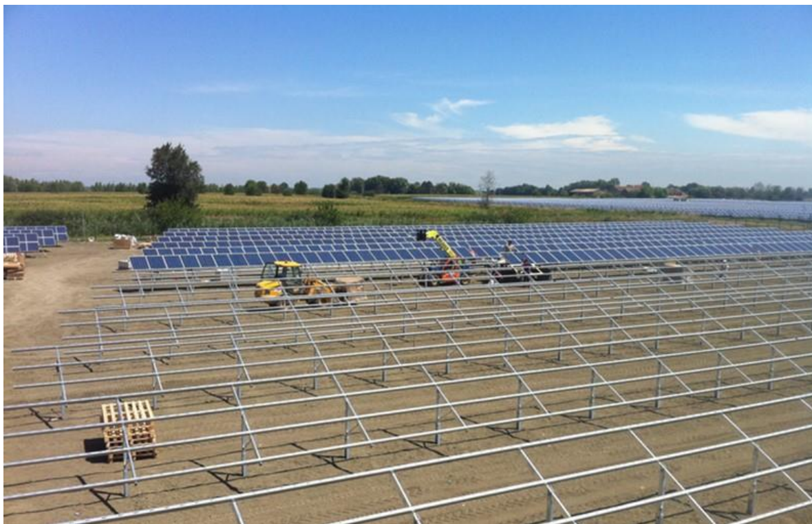
Rysunek 23 Proces montażu modułów fotowoltaicznych na konstrukcji szkieletowej Źródło: Archiwum własne
