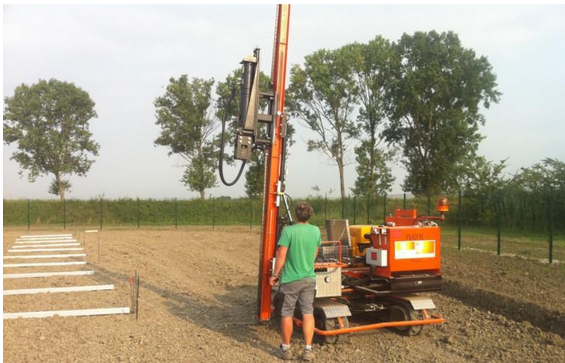
Rysunek 19 Katar do wbijania profili nośnych
