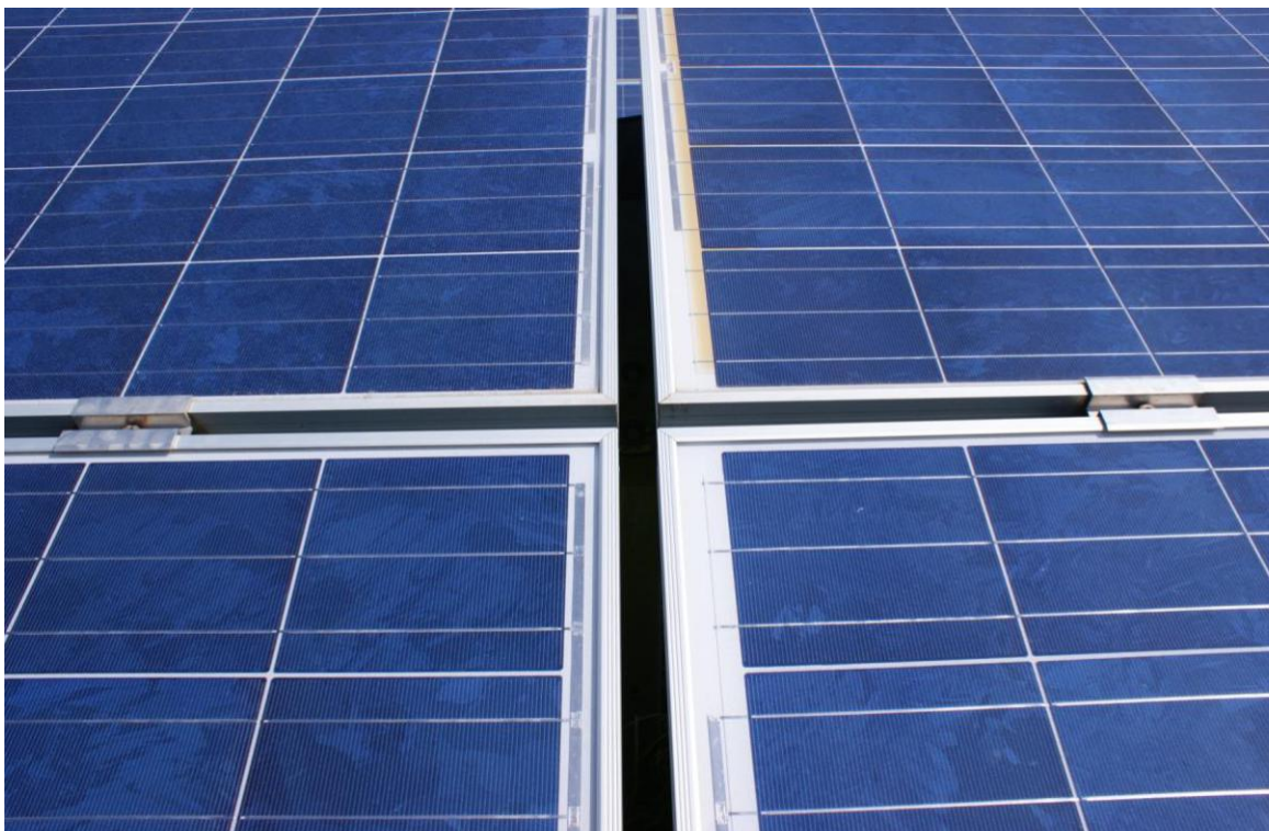
Rysunek 12 Sposób łączenia paneli fotowoltaicznych
