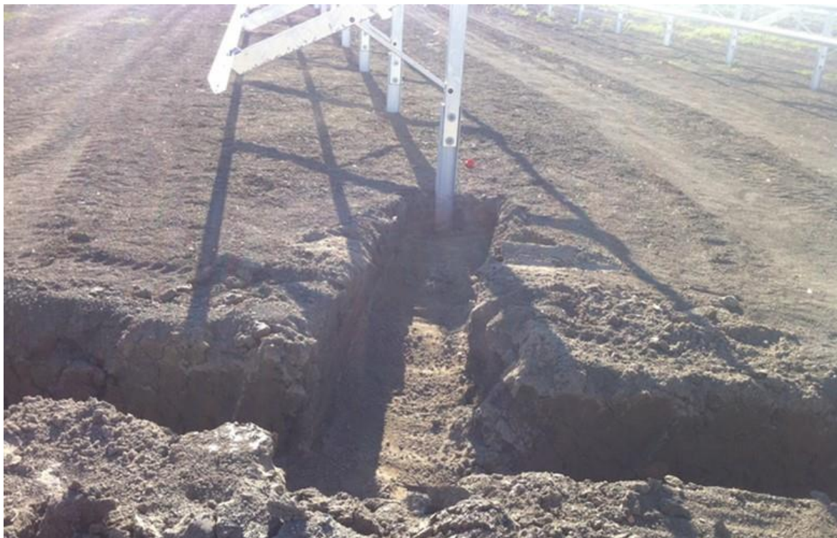
Rysunek 21 Skręcona konstrukcja nona modułów oraz otworzony wykop pod przewody elektryczne Źródło: Archiwum własne
