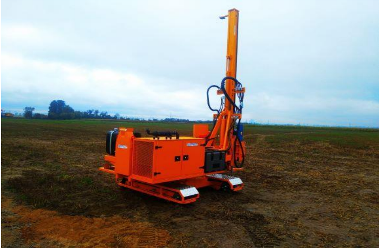
Rycina 4. Budowa konstrukcji za pomocą kafara.
