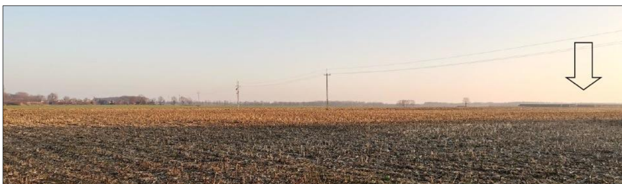
Ryc. 27. Zdjęcie elektrowni fotowoltaicznej z odległości ok. 450 metrów. Źródło: Materiały własne.
