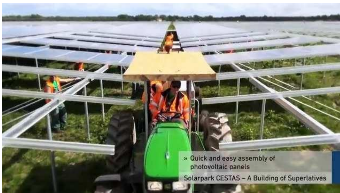
Rys. 11: Przykładowa konstrukcja stelaża na farmie Cestas w pobliżu Bordeaux (Francja).
