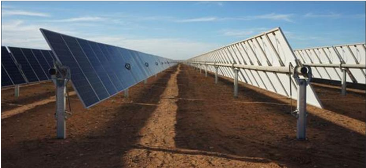
Rysunek 7 Przykładowa naziemna instalacja fotowoltaiczna wraz z zastosowanymi trackerami
