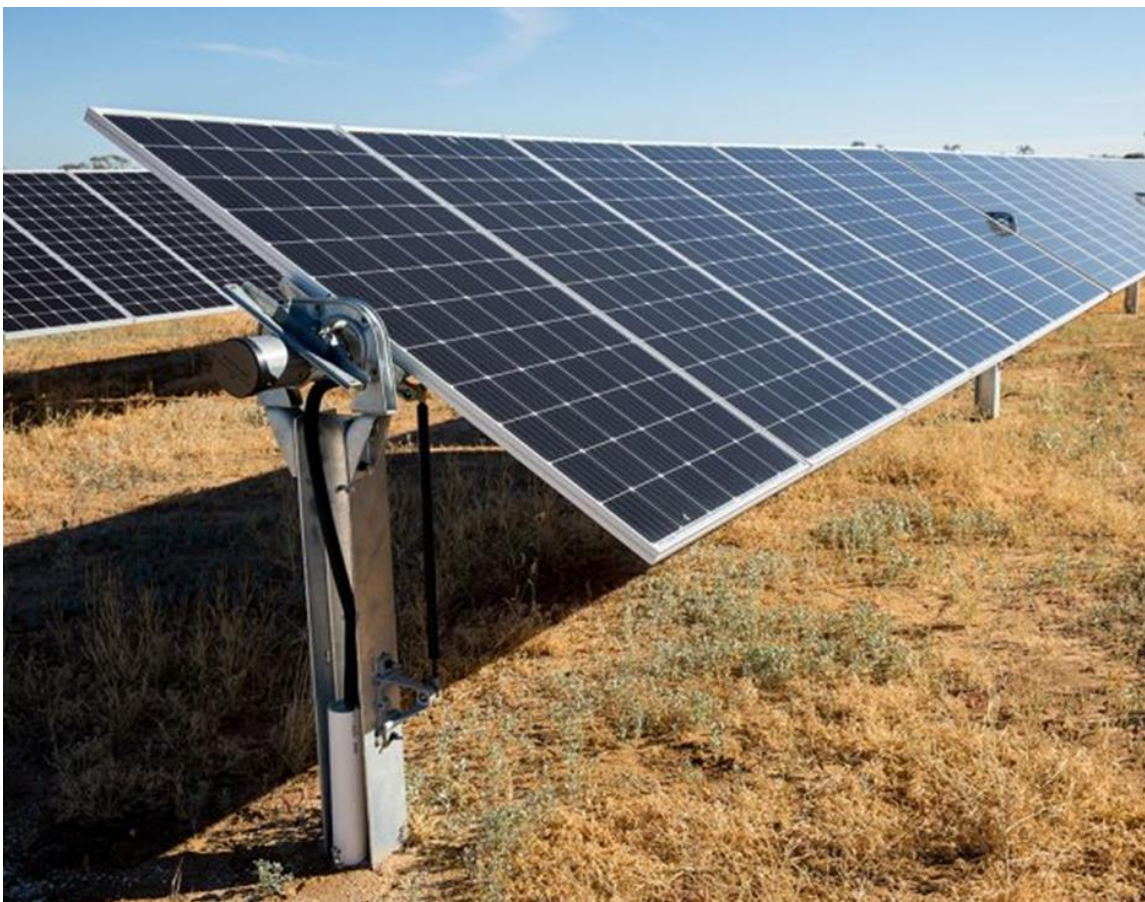
Rysunek 7 Przykładowa naziemna instalacja fotowoltaiczna wraz z zastosowanymi trackerami
