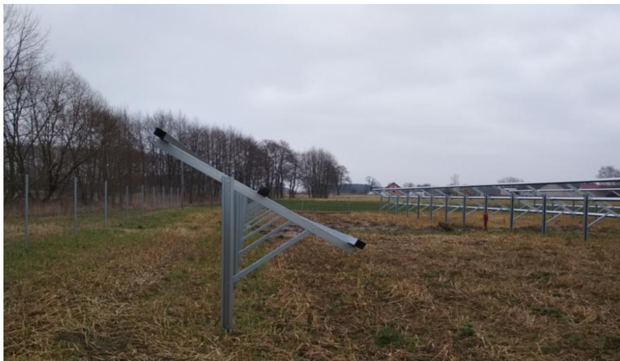
FOTOGRAFIA 3. Konstrukcje wsporcze przygotowane do montażu paneli fotowoltaicznych [foto: Paweł Kręciproch; instalacja w miejscowości Poddębice]
